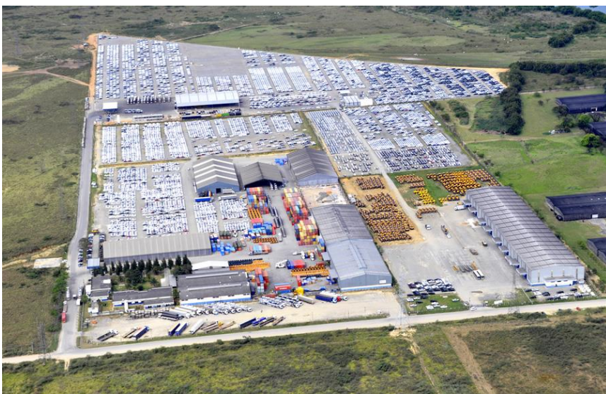
Figura 7 – Entreposto aduaneiro de Resende-RJ
