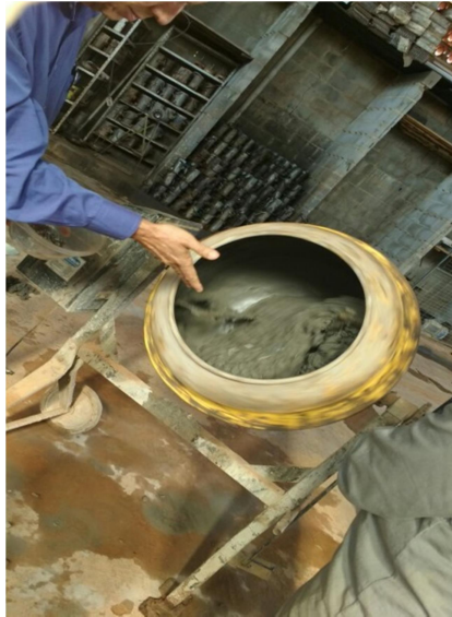
Figura 25 - Adição das fibras no concreto.
