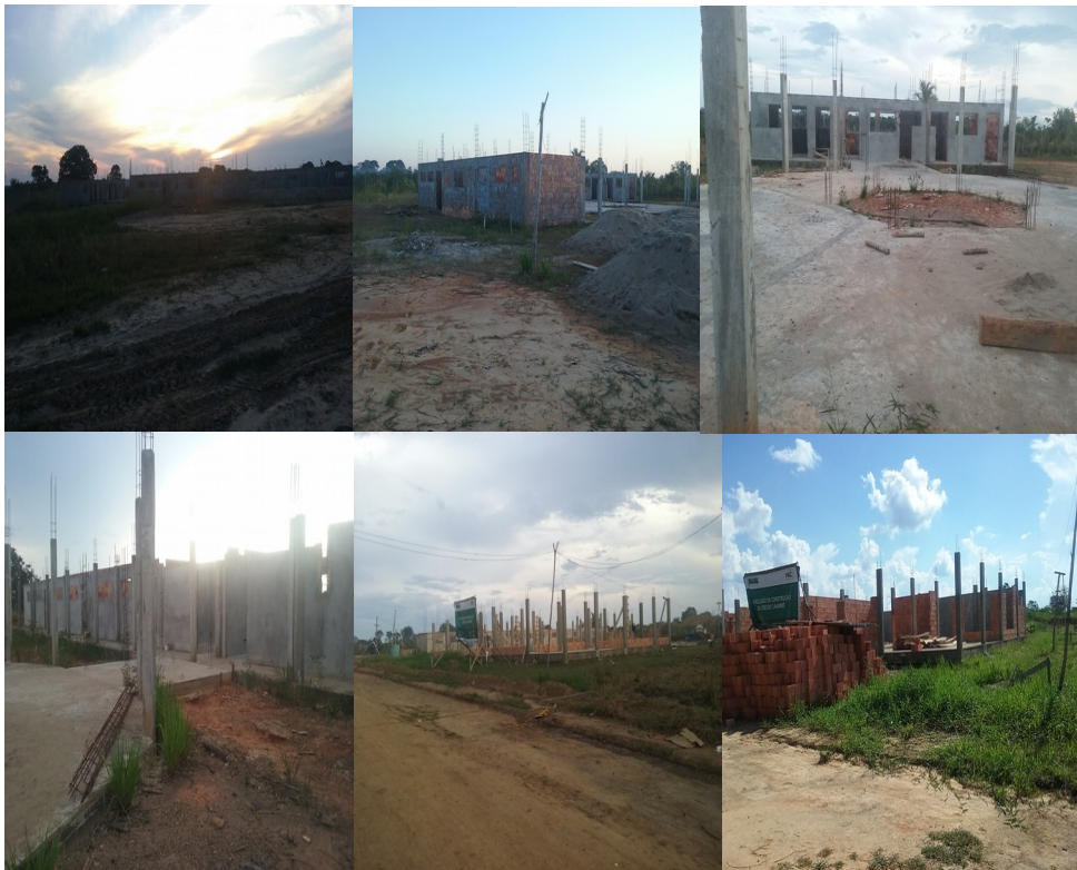
Figura 13: Mosaico de Fotos da Obra.
