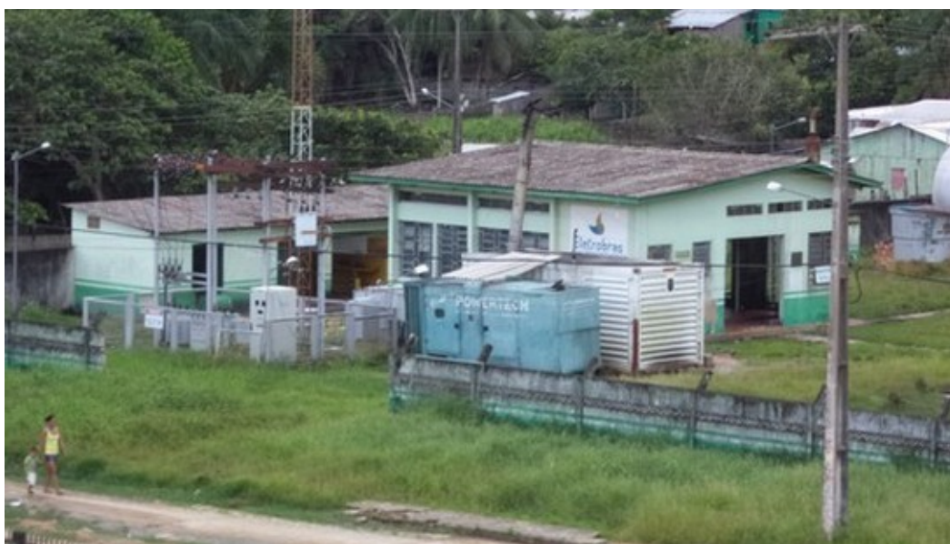
Figura 4: Usina termelétrica da Vila de Caiambé.
