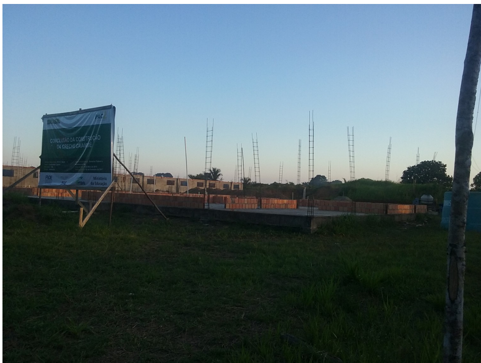
Figura 12: Foto Panorâmica da Obra.
