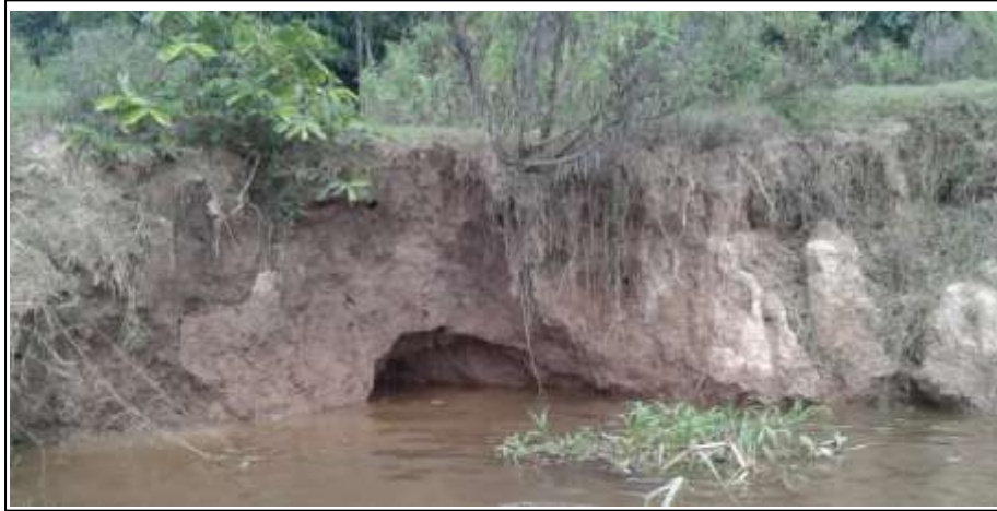
Figura 28: O solo minado pela umidade das águas do Paraná do Limão que escoam obedecendo ao declive do terreno facilitando o desmoronamento.
