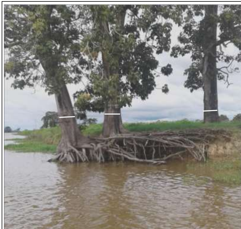
Figura 29: Imagem fotográfica de árvores às margens do Paraná do Limão com suas raízes nuas decorrentes da erosão do terreno. As marcas nos troncos das árvores indicam a altura da última cheia.
