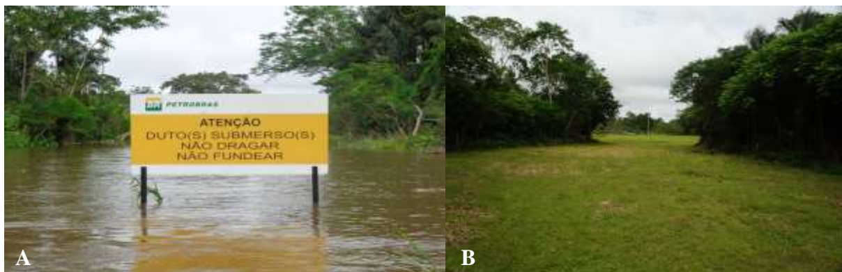
Figura 84: Placa de alerta da Petrobras (na cheia) e estrada dos dutos (na seca) em Esperança II
