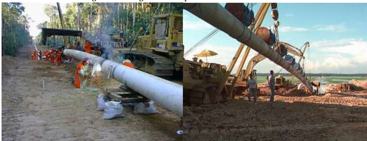
Figura 4: Soldagem e colocação de dutos flutuadores no rio
