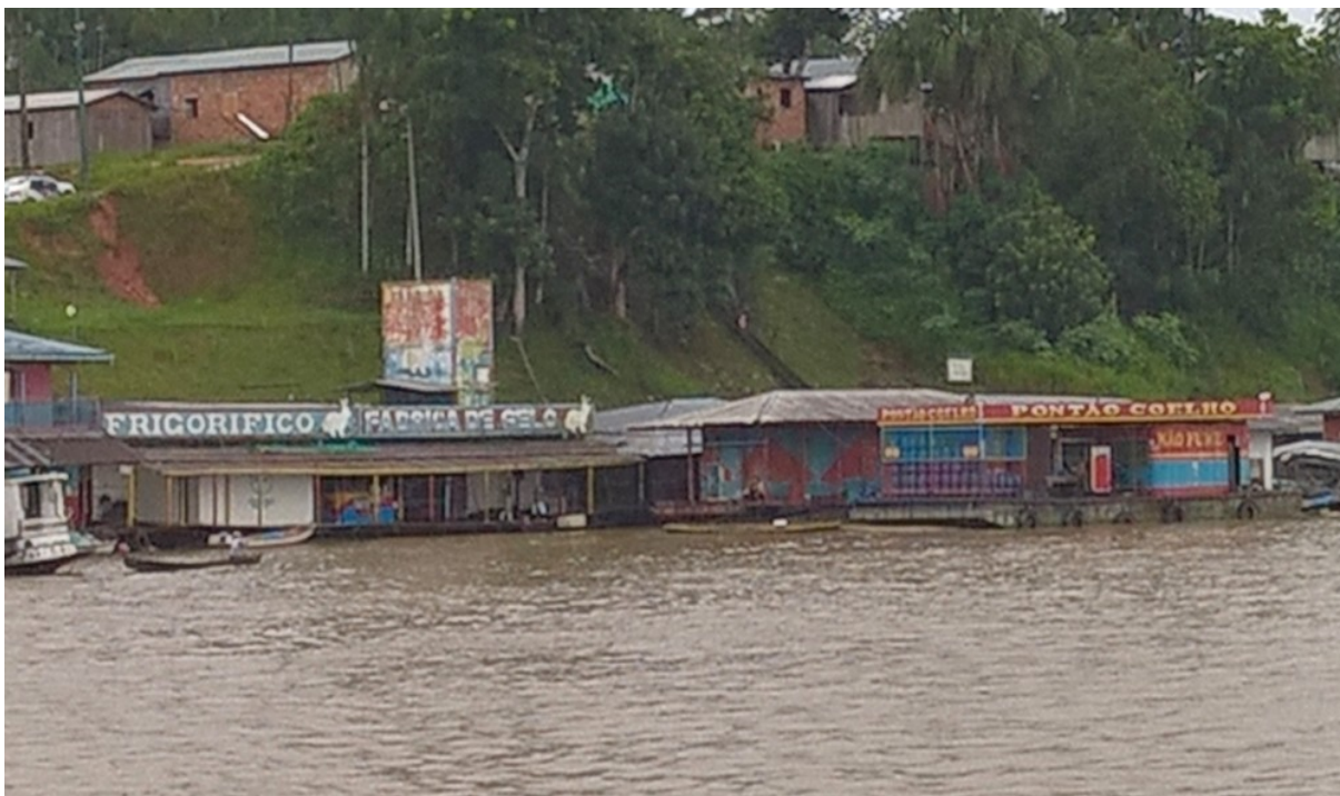
Figura 45 – Frigorífico, Fábrica de Gelo e Pontão Coelho.
