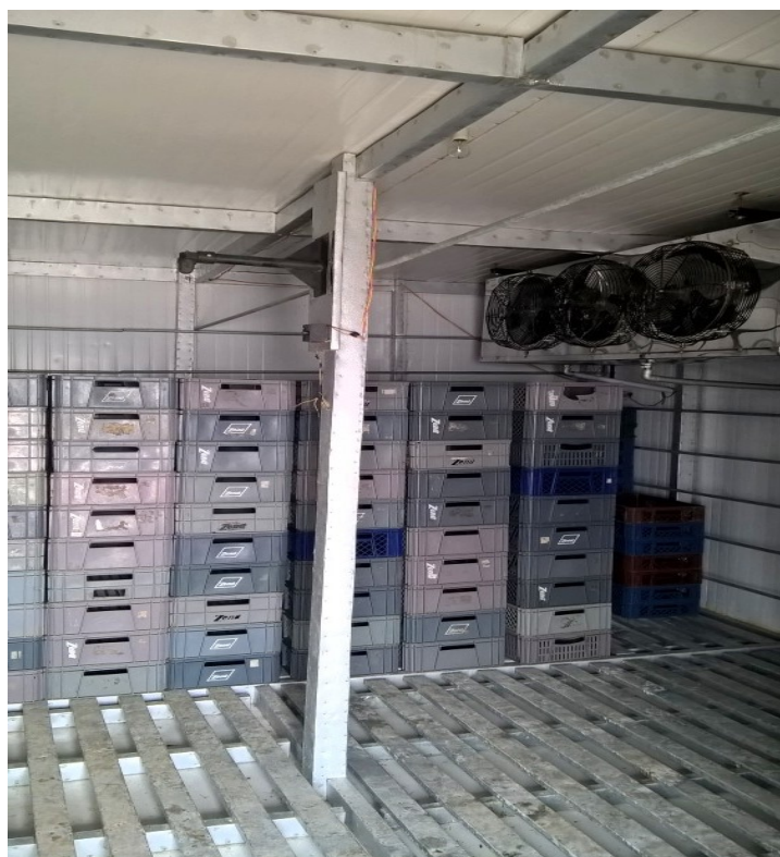
Figura 41 – Câmara de armazenamento do Frigorífico do "Lorinho" em Jutaí.
