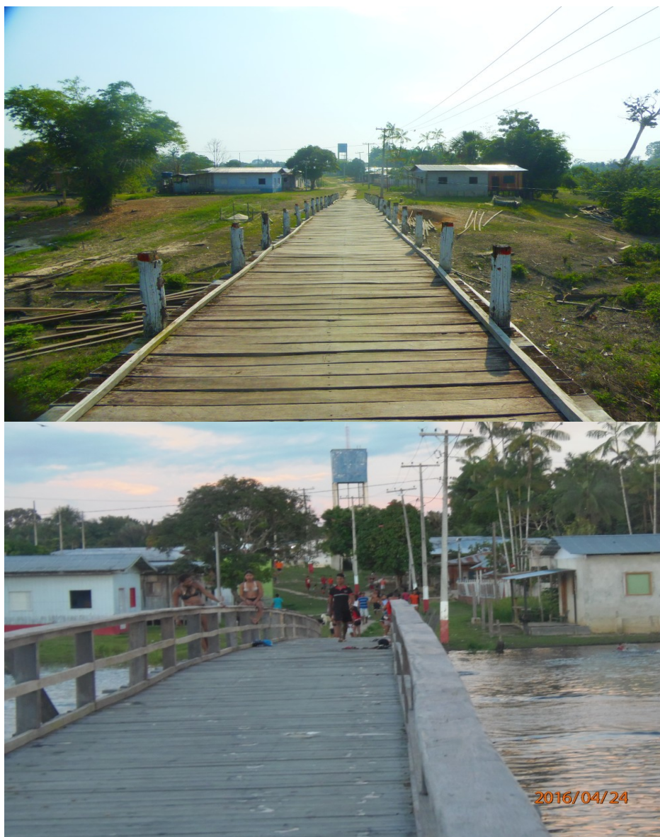
Figura 6 – Ponte que interliga os dois lados da Vila, a primeira registrada no período da seca e a segunda imagem (após uma reforma) registrada na época da cheia.
