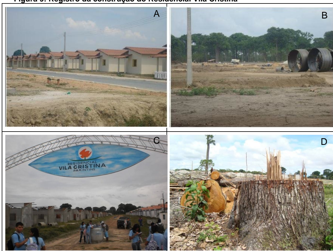
Figura 9: Registro da construção do Residencial Vila Cristina
