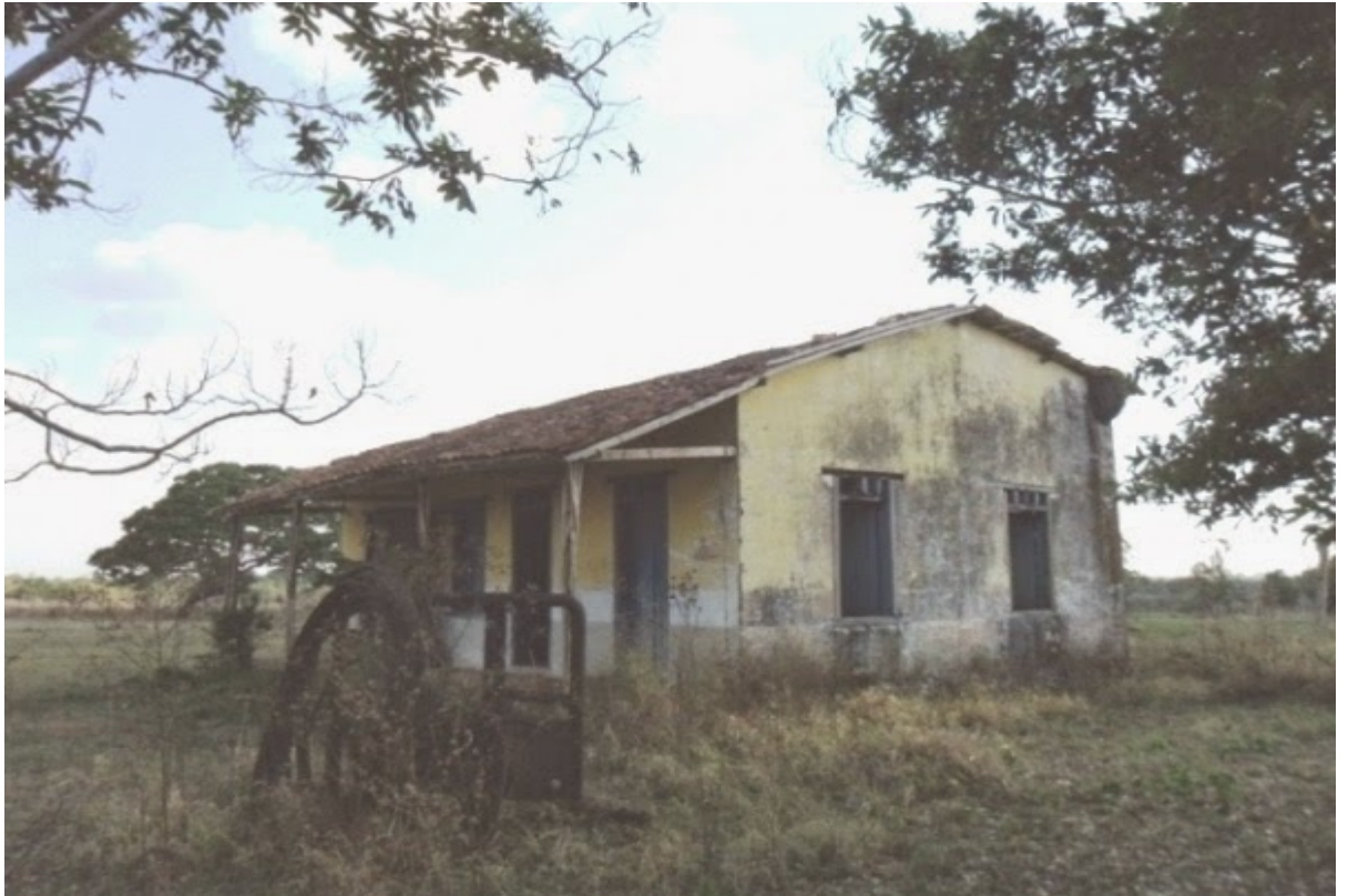
Figura: 1 Casa de Rondon abandonada em Vilhena - RO. Fonte: Ana Campana, 2015.
