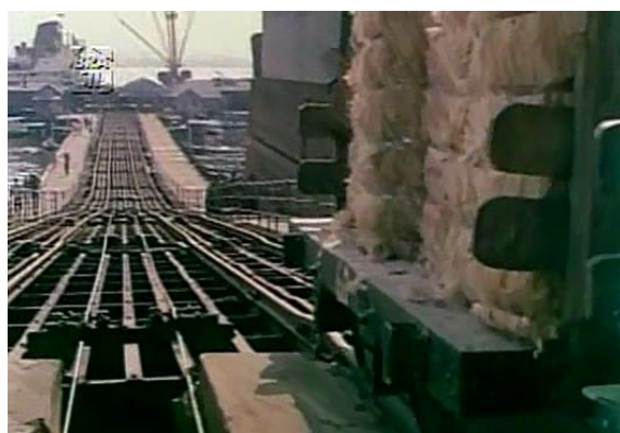
Figuras 46 e 47 – Transporte de carregamentos de juta no Porto de Manaus
