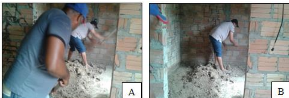
Figura 44 - Mutirão para construção de uma casa para uma agricultora do polo 1 do Projeto de Assentamento Nova Amazônia – Boa Vista/Roraima.
