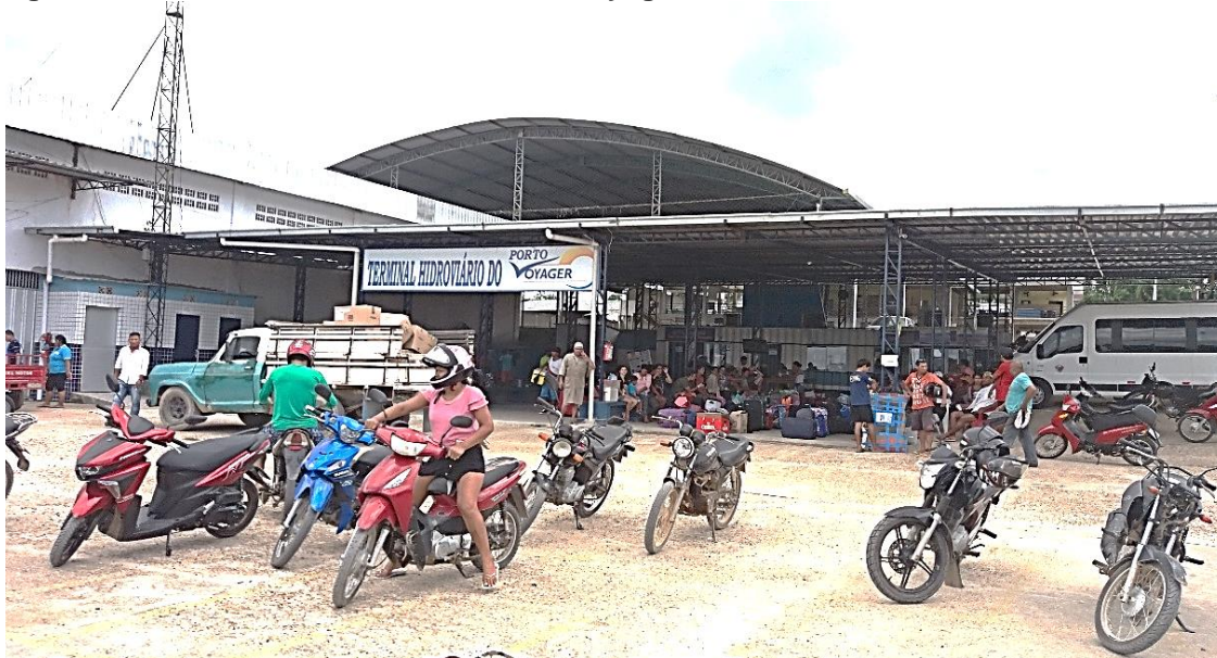
Figura 40 - Terminal Hidroviário do Porto Voyager
