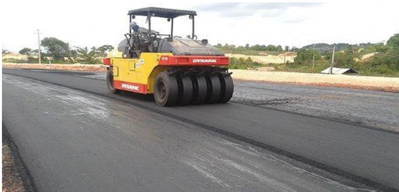
Figura 2.10 – Execução de revestimento em concreto betuminoso usinado a quente
