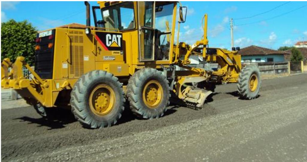
Figura 2.6 – Base executada em solo melhorado com cimento
