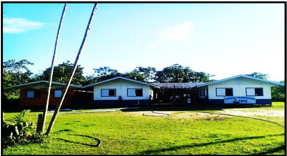
Figura 6: Escola Municipal Nossa Senhora do Perpétuo Socorro – o depois da reforma. Fonte: SOUZA, R. P. (Outubro de 2017).
