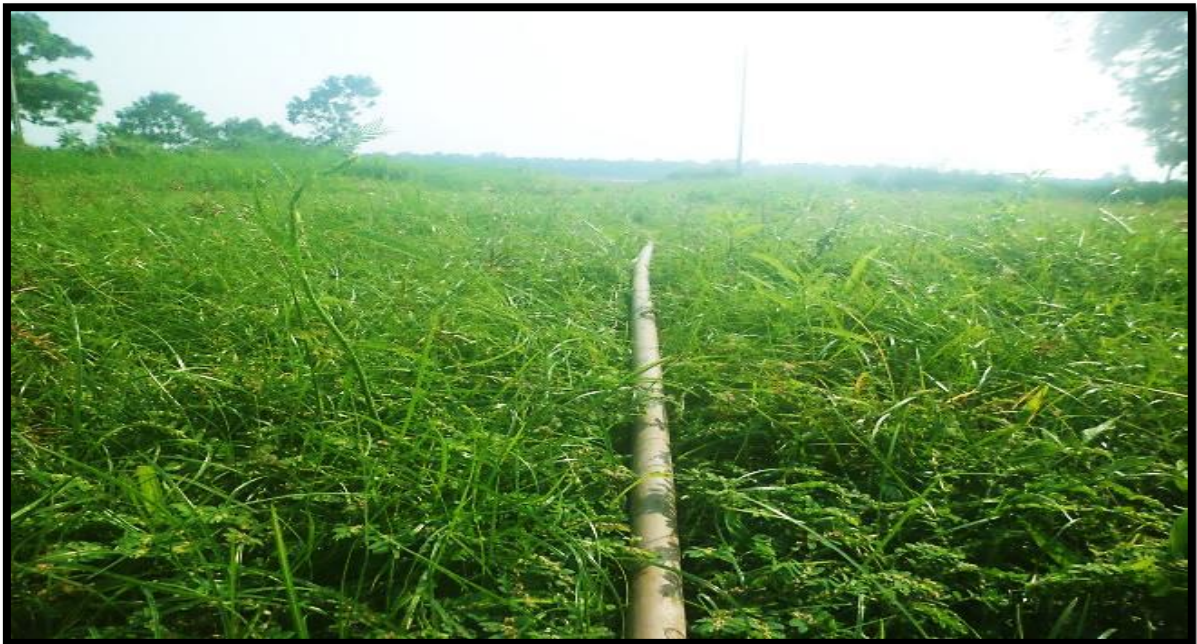
Figura 19: Cano, localizado na parte central na figura, que puxa água do rio Solimões para o consumo dos moradores da comunidade de Nossa Senhora do Perpétuo Socorro na época da seca. Fonte: SOUZA, R. P. (Outubro de 2017).
