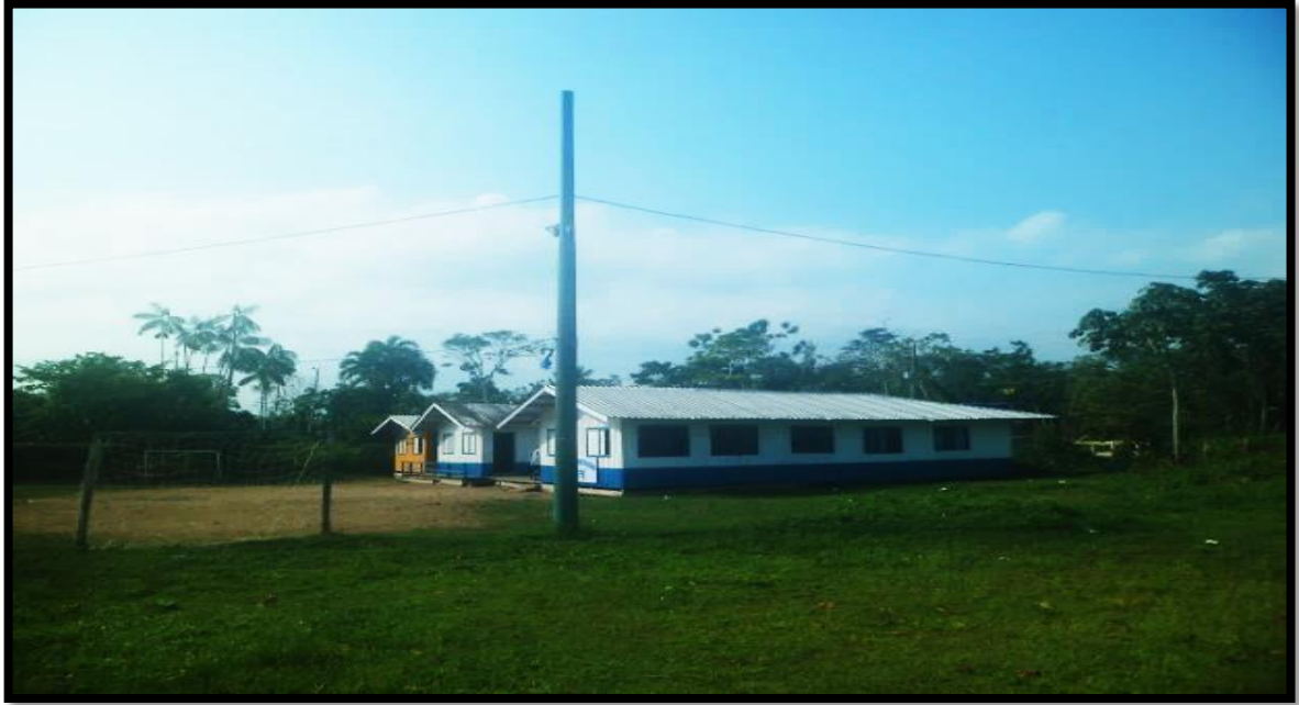
Figura: 10: Poste na comunidade de Nossa Senhora do Perpétuo Socorro, localizado no centro da imagem (Tefé-AM). Fonte: SOUZA, R. P. (Outubro de 2017).
