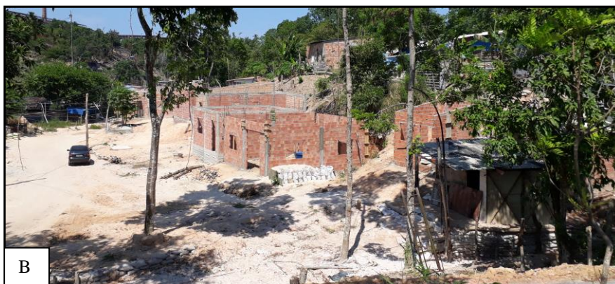
Figura 68: Construções em área inapropriada, próximo à voçoroca no afloramento ED-07 (Porto da Ceasa), primeira (A) e terceira (B) etapa de campo
