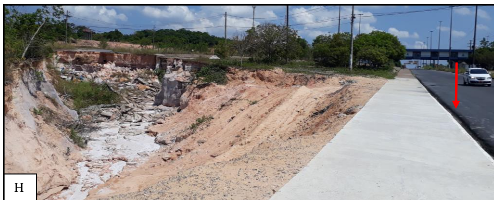
Figura 46: H) contenção de uma parte da voçoroca e recuperação da calçada e da via
