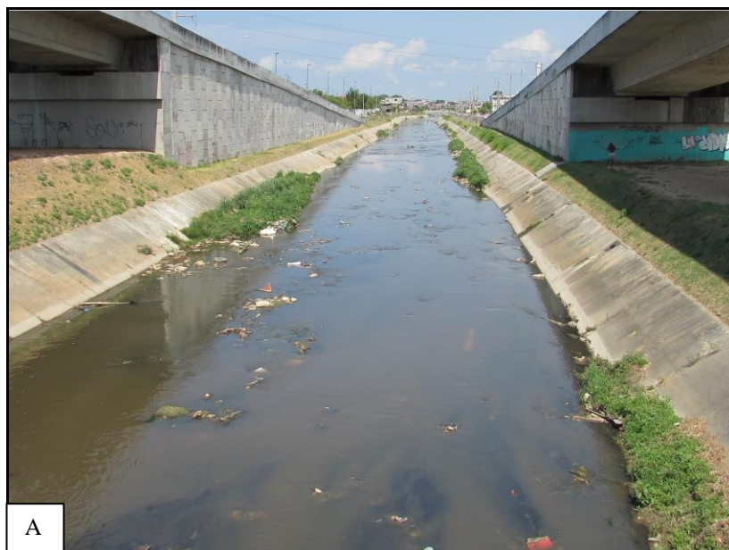
Figura 66: A) Retificação do Igarapé do Quarenta, próximo ao Sistema Viário do Quarenta (viaduto do Japiim)
