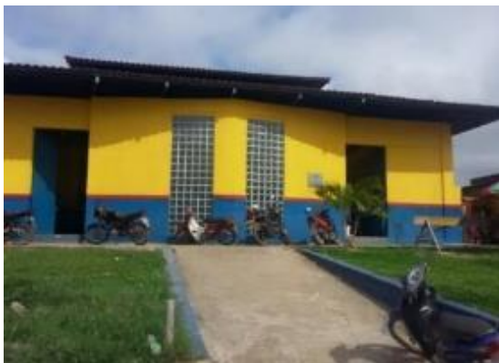
A: Vista da área externa do prédio
