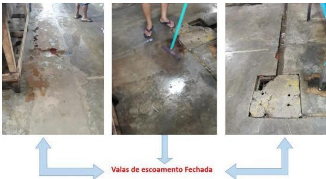
Figura 11 - Valas de escoamento da água na feira do peixe já fechadas.
