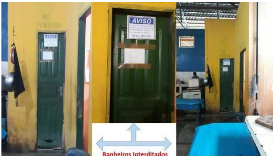
Figura 12 - Banheiros Interditados para o uso dos Trabalhadores.
