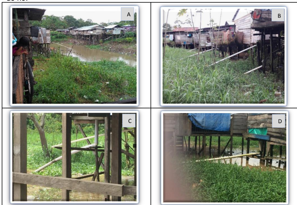
Figura 19 – Fotografias da comunidade Guadalupe, Tabatinga-AM. (A) mostrando os esgotos das casas dos moradores direcionados à margem do igarapé, à céu aberto, em período de seca do rio; (B), (C) e (D) mostrando os canos dos sanitários das casas dos moradores despejados nas águas do igarapé, em período de cheia do rio.
