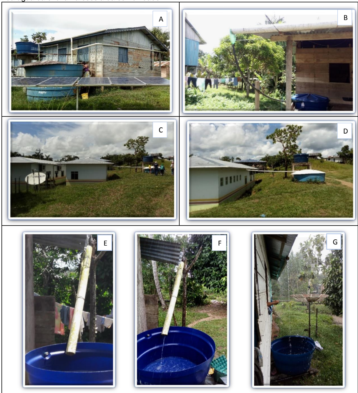
Figura 17 – Fotografias destacando a captação de água da chuva na comunidade Nova Aliança, Benjamin Constant, AM. (A) local de captação de uso coletivo, com bombeamento e uso de energia solar; (B), (E), (F), (G) captação da água da chuva nas residências dos moradores; (C) e (D) captação da água da chuva na escola da comunidade.
