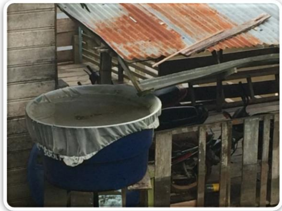
Figura 16 – Fotografia mostrando a captação da água da chuva na casa de um morador de Guadalupe.
