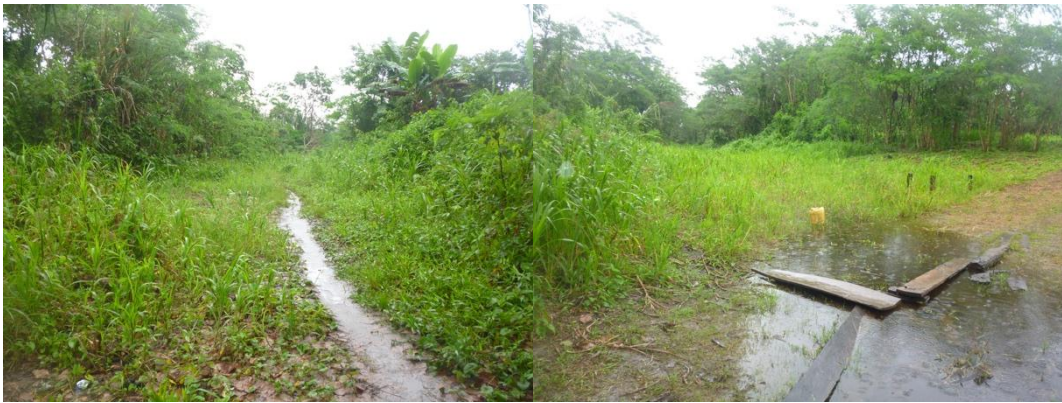
Figura 16- canal principal da Comunidade de São José, Benjamin Constant, AM
