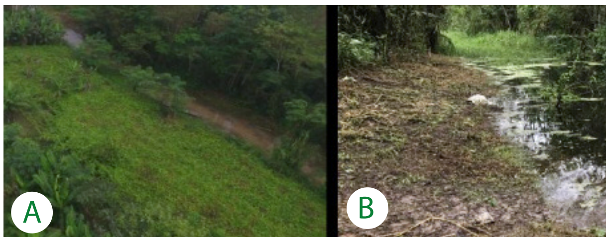
Figura 7: A)Vista aérea da área da rede elétrica da Comunidade de São JoséB)Canal da Comunidade de São José.
