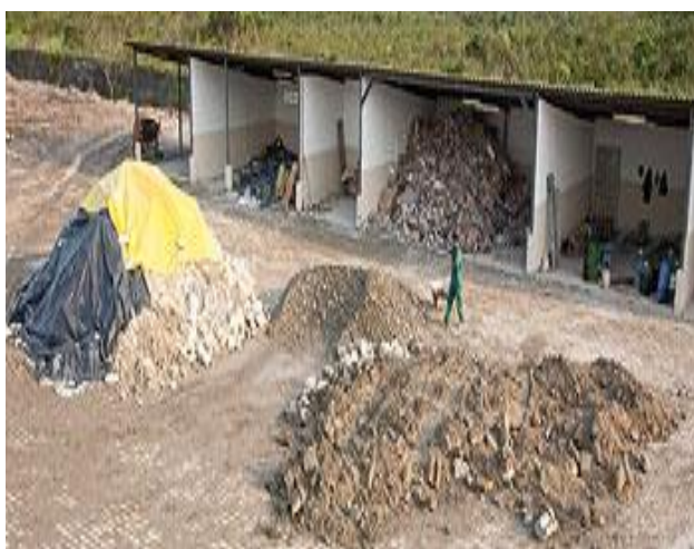
Figura 2: Resíduos Reutilizáveis. Agregados. Fonte: Pini. Equipe de obra, 2017.
