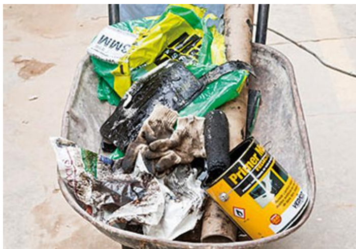
Figura 4: Resíduos Reutilizáveis. Tintas; Solventes; Amianto. Fonte: Pini. Equipe de obra, 2017.
