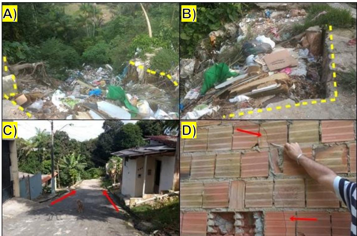
Figura 19: A) e B) linhas tracejadas amarelas indicam os pontos de expansão da erosão que começa a atingir o asfalto. C) setas vermelhas apontam a direção do escoamento urbano. D) setas vermelhas destacam rachaduras encontradas em residência instalada nas proximidades da incisão erosiva.
