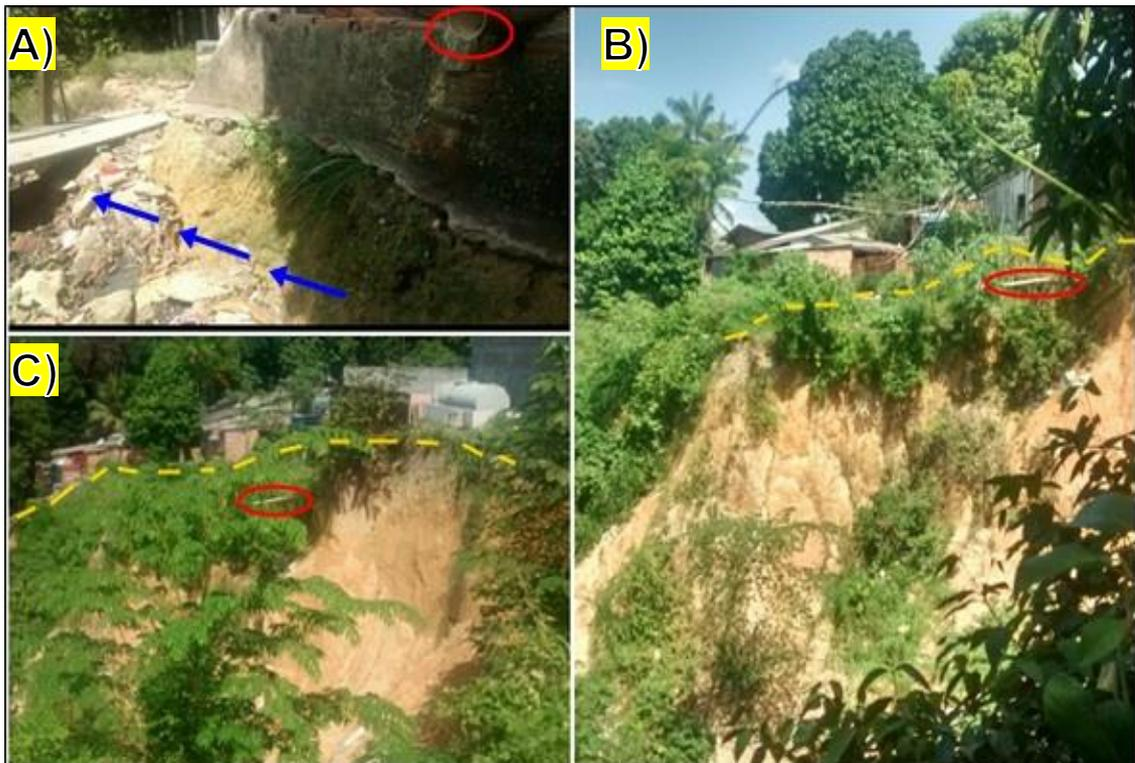
Figura 14: A) setas azuis indicam a direção de fluxo dos efluentes; B) e C) linhas tracejadas amarelas indicam a borda da voçoroca. A elipse vermelha está sobre o sistema de drenagem residencial.
