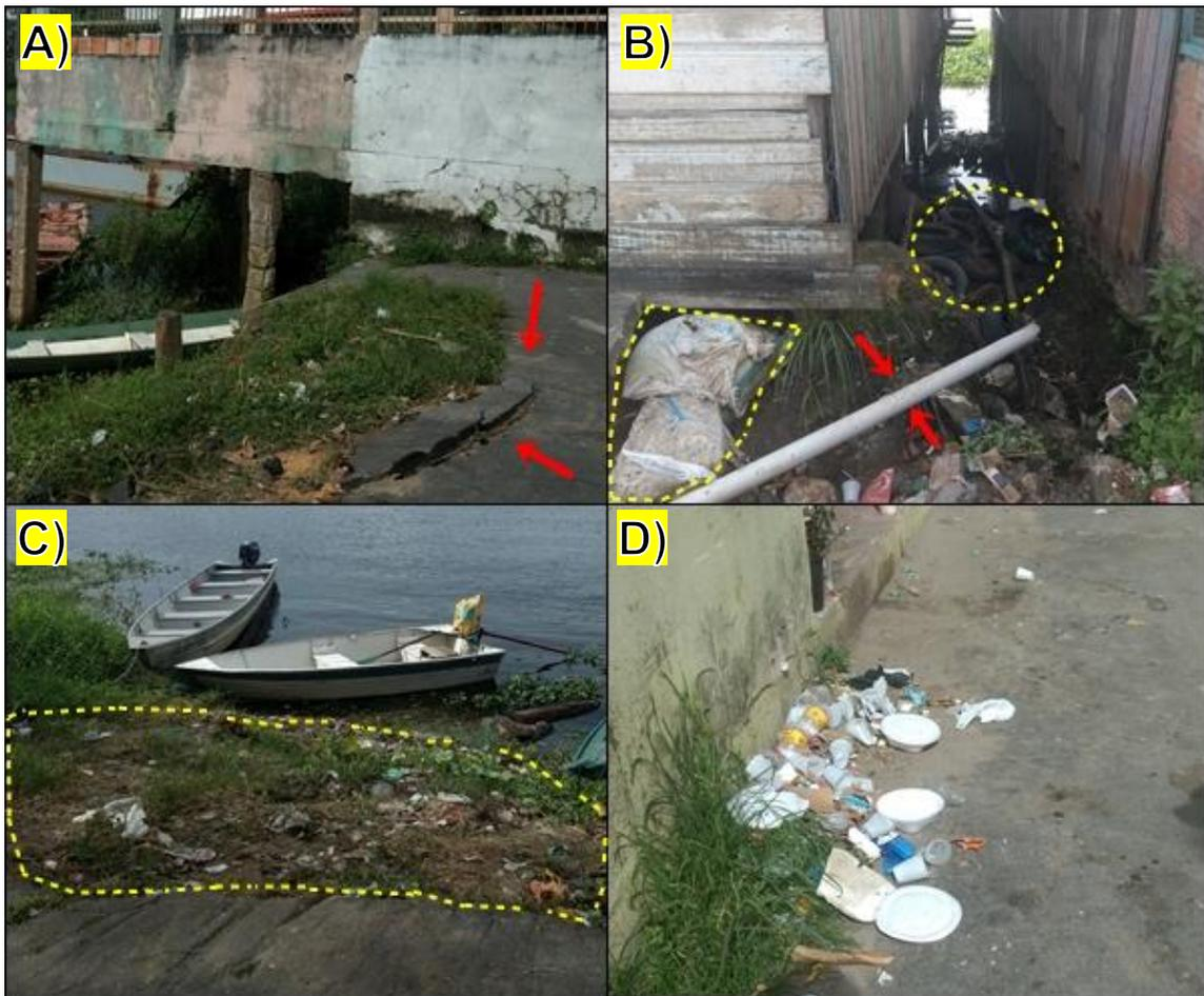
Figura 26: A) setas vermelhas indicam ponto em que o asfalto está cedendo; B) linhas amarelas tracejadas destacam sacos com areia e pneus usados para conter a ação das águas; C) linhas amarelas tracejadas destacam a presença de lixo na margem da bacia. Setas vermelhas apontam para cano utilizado no despejo de resíduos em direção a bacia; D) resíduos descartados próximos a bacia.
