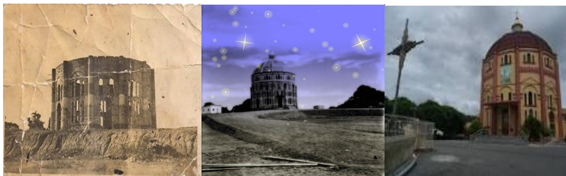
Figura 12. Construção da Igreja N. S. de Fátima
