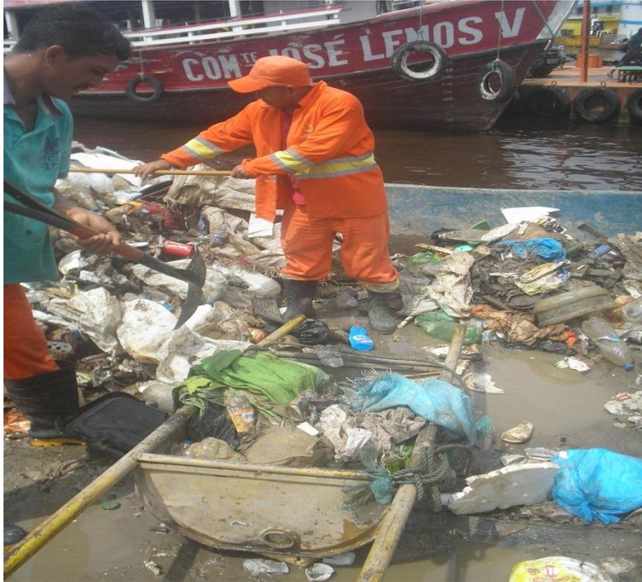
**Figura 52:** Enchimento da padiola com resíduos retirados de montante de lixo acumulado na balsa, para pesagem e formação de amostra para análise semigravimétrica (10/12/2016)
