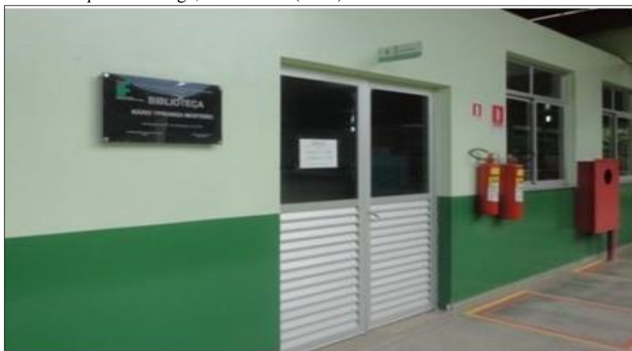
Figura 23. Representação Fotográfica da fachada da Biblioteca Mário Ypiranga IFAM Campus Tabatinga, Amazonas. (2018).
