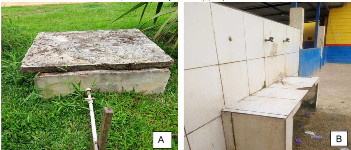
Figura 14: Fontes de abastecimento mais acessados no bairro Santa Rosa, Tabatinga, AM. (A) Poço tubular dentro de estrutura em alvenaria, em residência particular. (B) Poço tubular de uso comunitário.
