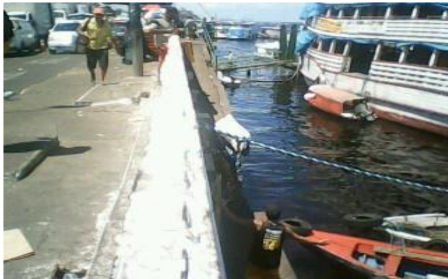
05. Muro de arrimo entre a Avenida e a praia. Acervo Rafaela Bastos.
