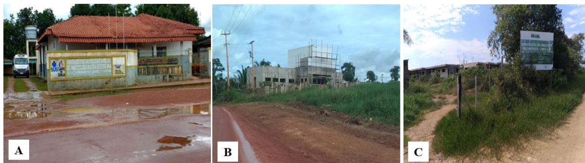
Figura 29 - USF e construção do prédio da nova USF, creche e a pré-escola no Distrito de Miritituba, em Itaituba-PA.
