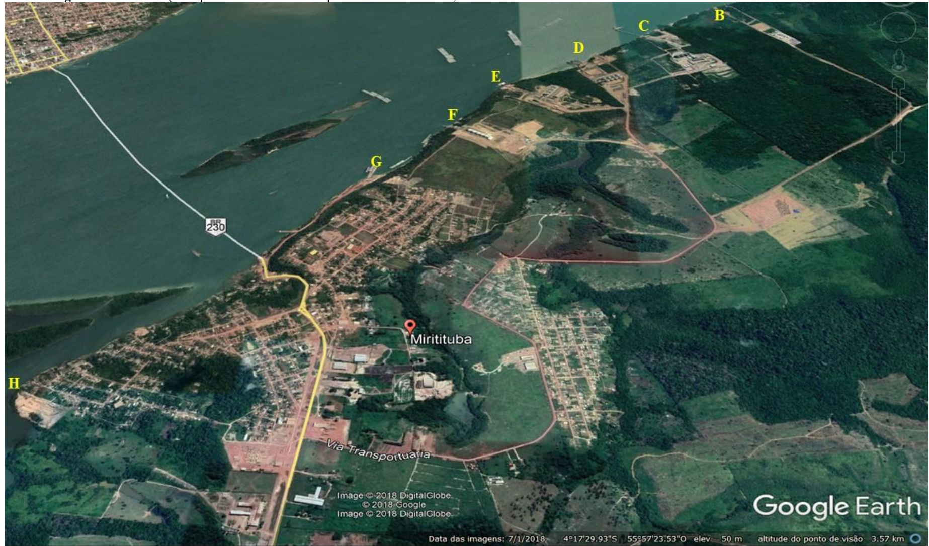
Figura 21 - Distribuição espacial da infraestrutura portuária em Miritituba, Itaituba –PA
