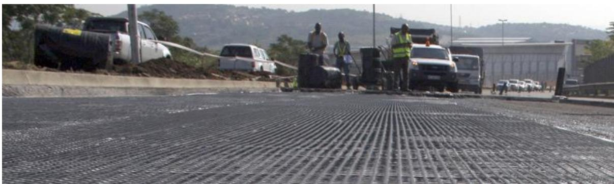
Figura 14 - Manta MacGrid® sendo aplicada em obra de pavimentação.
