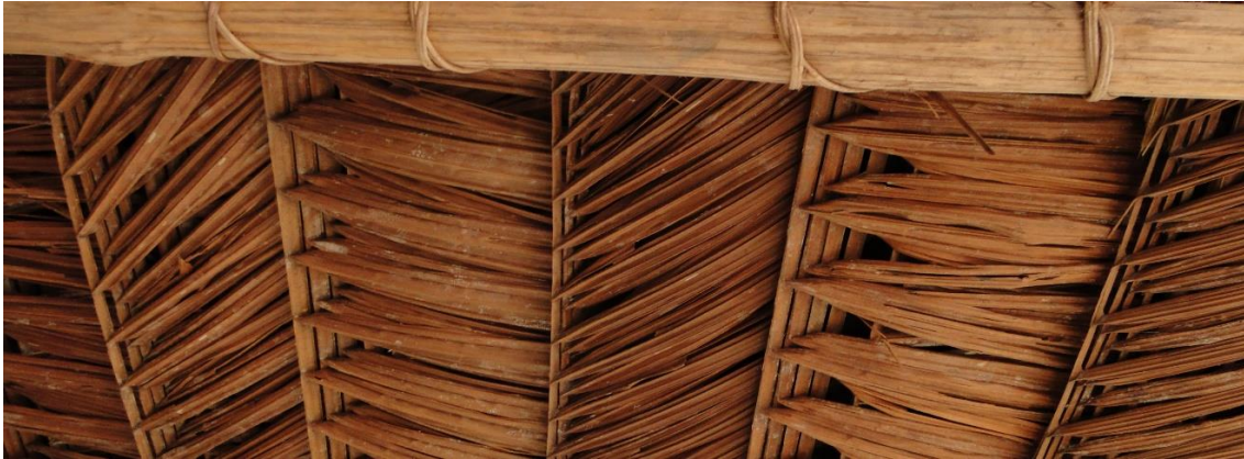
FIGURA 6 – TELHADO DE PALHA DA PIAÇAVA. OSOEGAWA, DIEGO K.2016.
