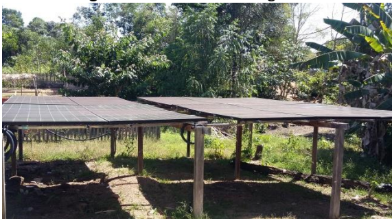
Figura 18 - Placas de energia solar
