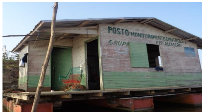
Figura 17: Base Flutuante de monitoramento do Igarapé do Bom Sucesso (sem uso) Foto: PIRES, 2014.
