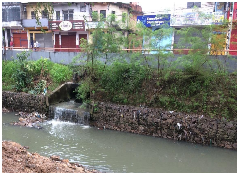
Figura 9 - Tubulações de escoamento próximo ao IF1
