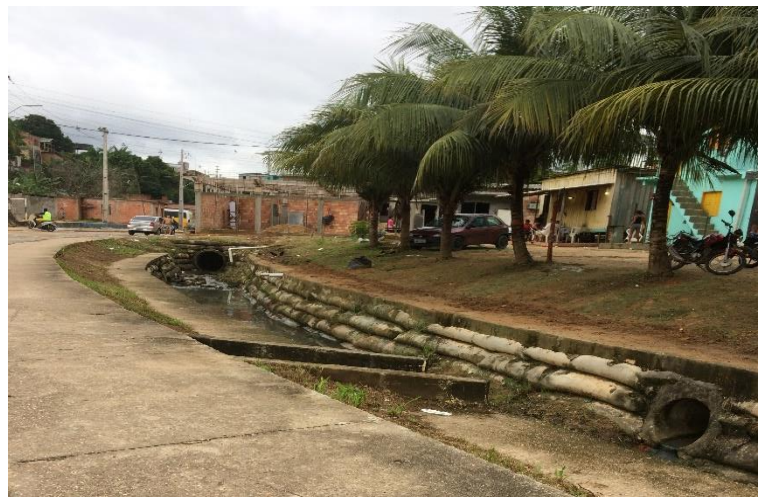
Figura 3 - Nascente do Igarapé do Franco - Aspecto Visual
