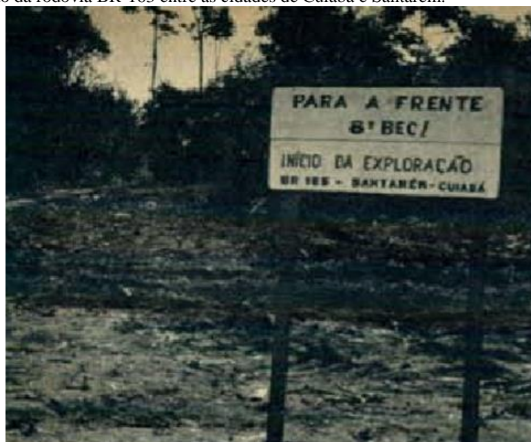
Figura 6. Construção da rodovia BR-163 entre as cidades de Cuiabá e Santarém.
