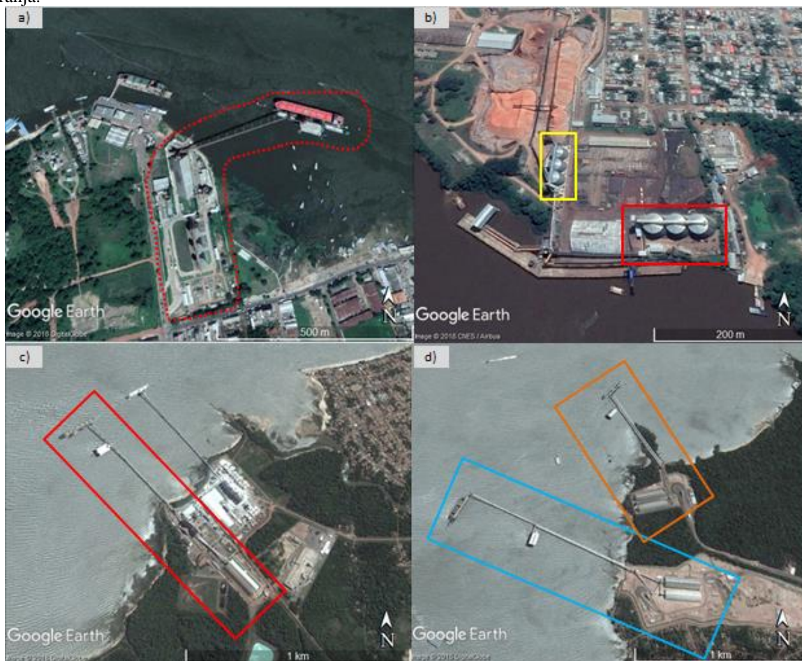
Figura 29. No mosaico: a) Porto da Cargill, em Santarém – em linha pontilhada vermelha; b) Companhia de Docas de Santana –silos de armazenagem da empresa Caramuru, em retângulo de linha amarela/silos da empresa Cianport, em retângulo de linha vermelha; c) porto da ADM, em linha vermelha; d) porto da empresa Hidrovias do Brasil, em retângulo de linha azul, e o porto da empresa Bunge-Amaggi –Tefron, em retângulo de linha laranja.
