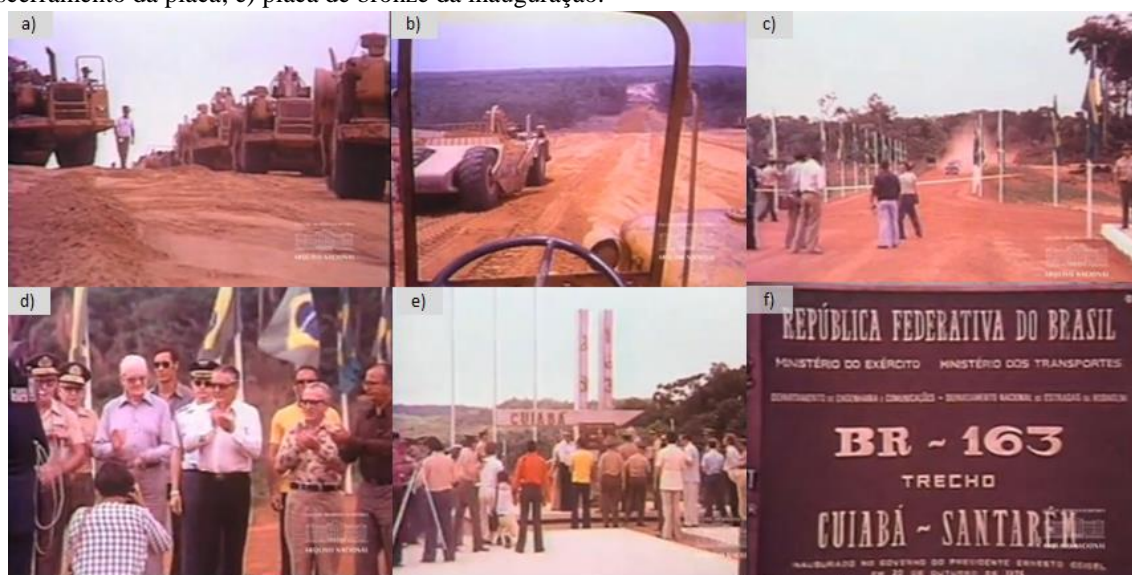
Figura 7. Construção e inauguração da rodovia BR-163, no trecho entre Cuiabá e Santarém: a) moto escrapers fazendo terraplanagem; b) obras de aterro; c) chegada do presidente; d) presidente e seus ministros; e) descerramento da placa; e) placa de bronze da inauguração.
