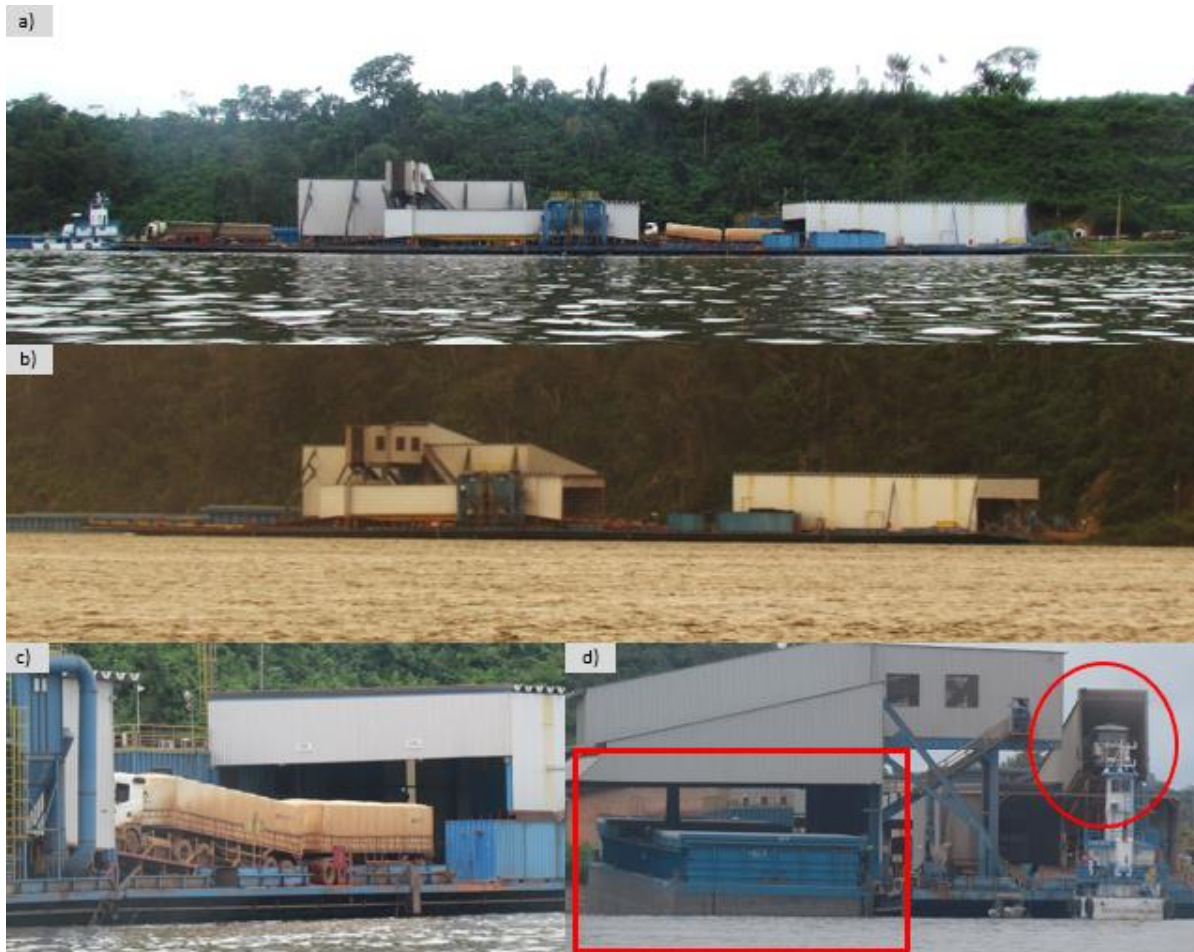
Figura 35. No mosaico, o terminal de transbordo de carga da empresa Bertolini: a) e b) ETF; c) carreta Rodotrem subindo a rampa de acesso ao tombador; d) área de carregamento da balsa em quadro vermelho e uma carreta dentro do tombador em círculo vermelho.
