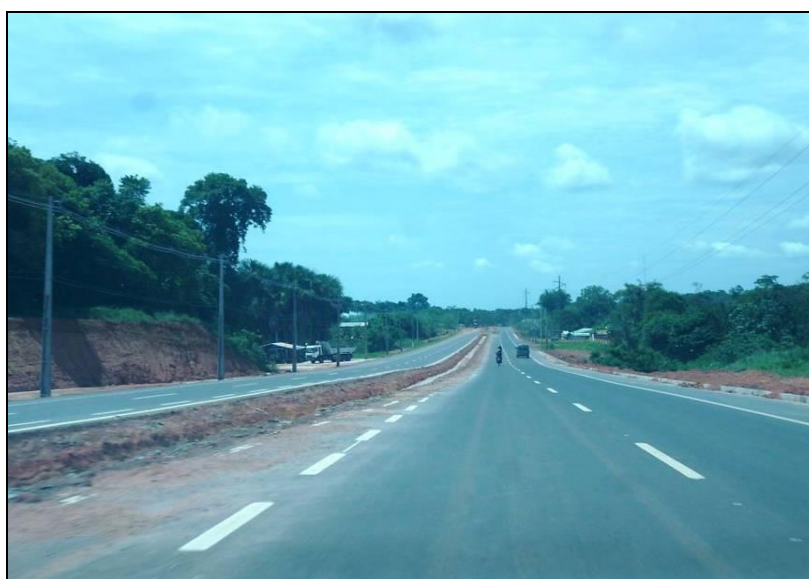
Figura 54 ã Representação fotográfica de obras de duplicação da rodovia AM-070
