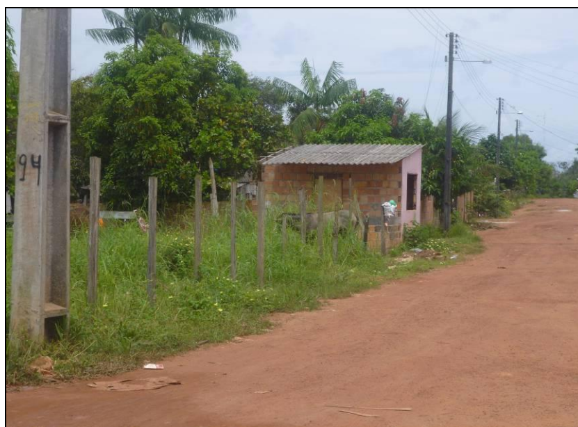
Figura 31 ã Representação fotográfica de Rua sem asfaltamento na cidade de Iranduba/AM.
