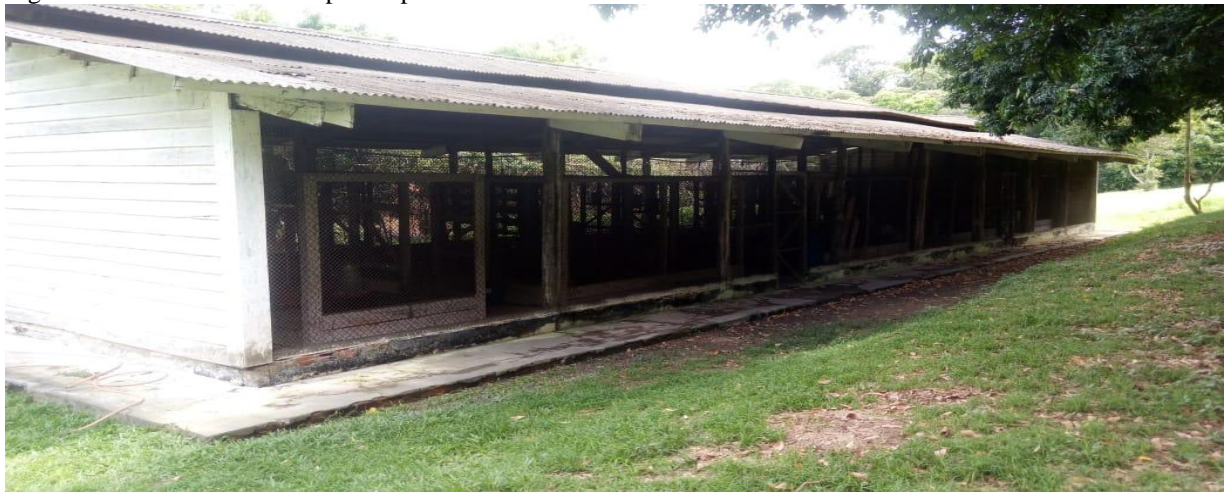
Figura 2 - Vista lateral do Galpão Experimental no Setor de Avicultura da Universidade Federal do Amazonas
