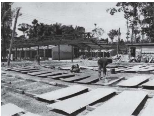
Escurecimento das Coberturas
