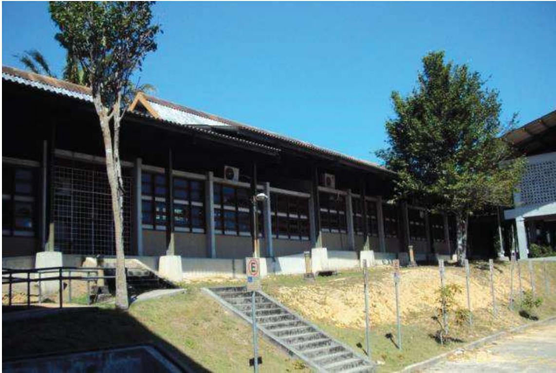
Figura 2 – Bloco de laboratórios 11 - FT. Fonte: Mendes, 2017.
