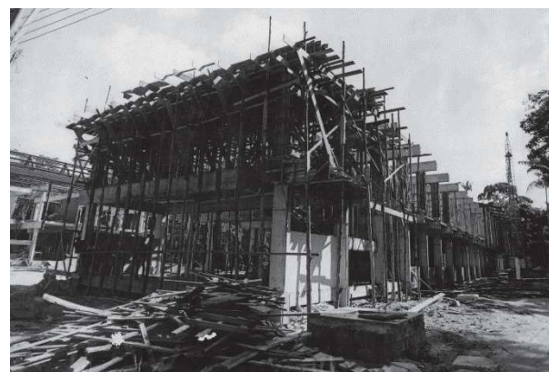
Estrutura das Edificações
