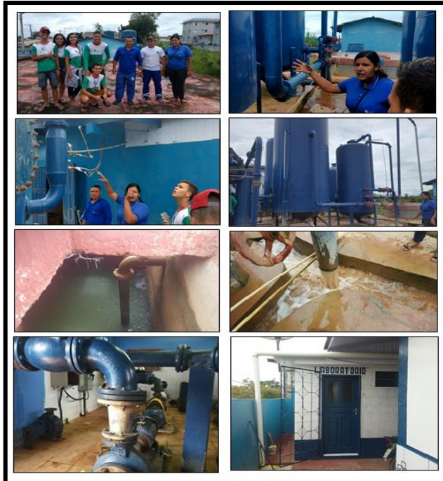
Figura 23 - Visita à Estação de Tratamento COSAMA
