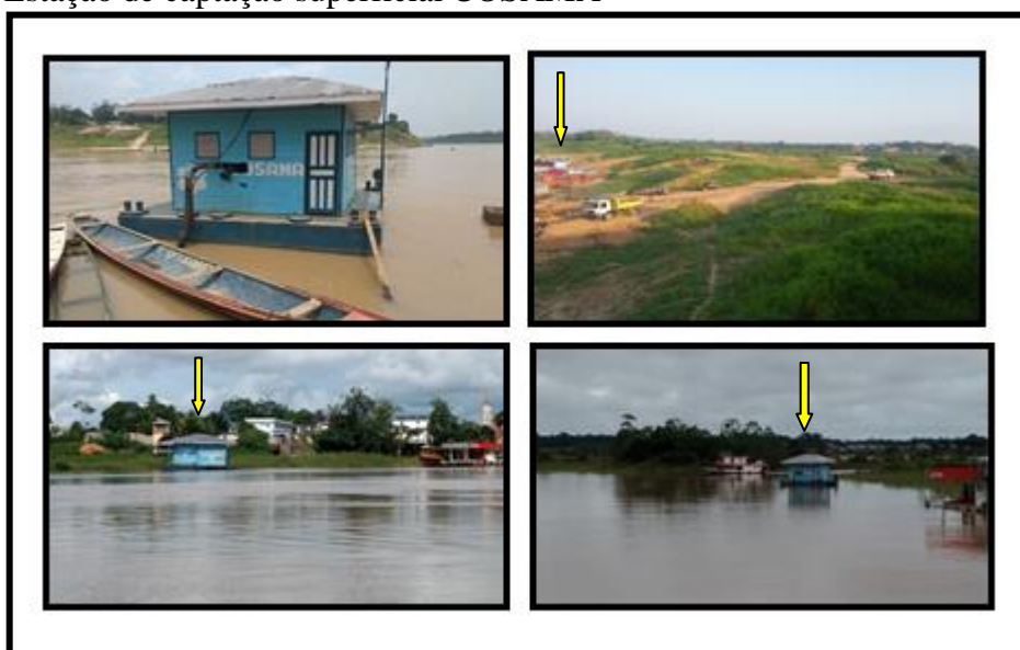
Figura 7- Estação de captação superficial COSAMA
