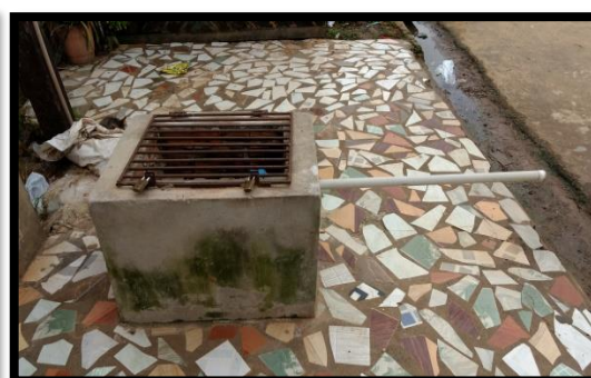
Foto 6: Poço São José (Gomes, 2017)
