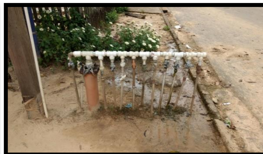
Foto 4: Poço B São José (Gomes, 2017)
