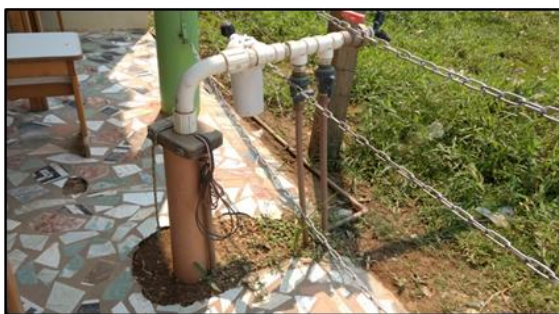
Foto 1: Poço tubular profundo (Gomes, 2017).
