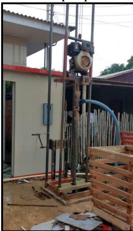
Figura 17 – Perfuratriz usada para perfurar os poços em Eirunepé.
