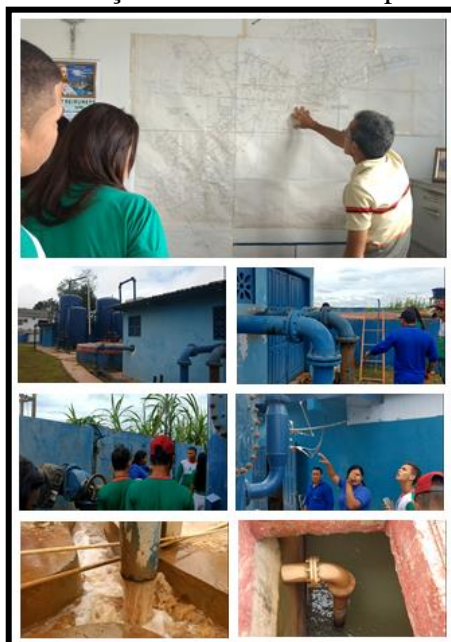
Figura 18 - Visita a Estação de Tratamento superficial da COSAMA
