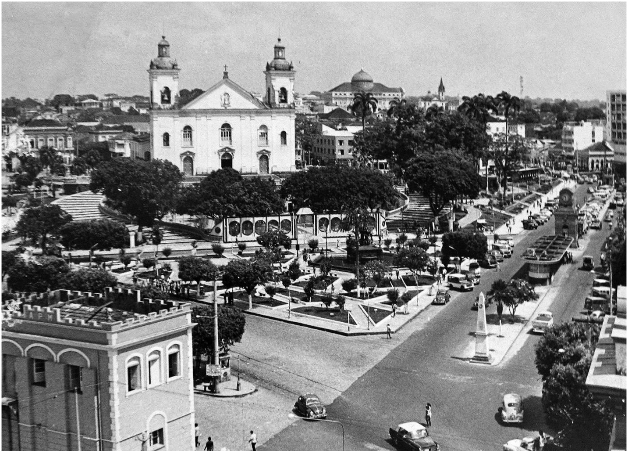
Figura 15 - Vista original da fachada da Catedral Metropolitana e dos jardins do Parque da Matriz
