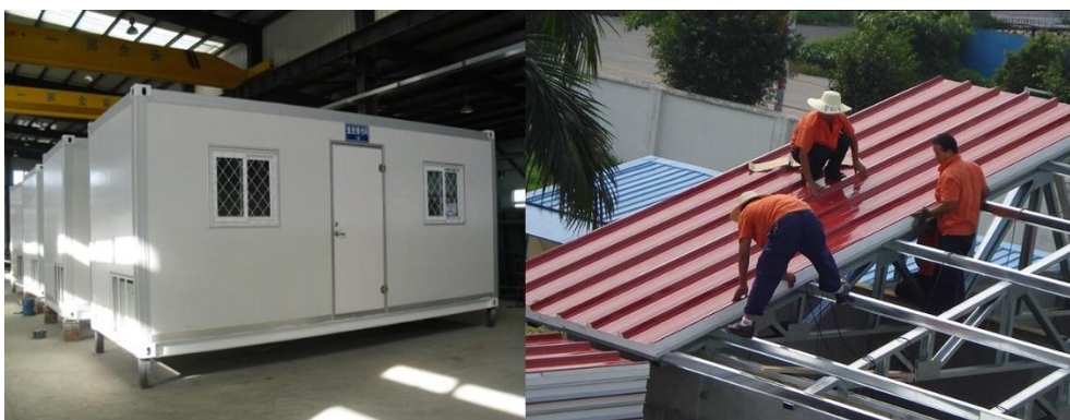
Figura 8. Utilização do painel sanduíche na Construção Civil (SHHANYAO, 2018)
