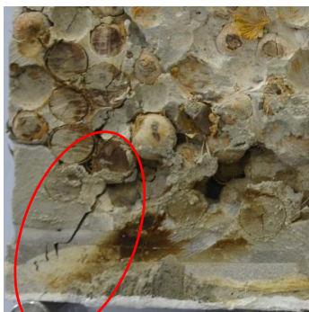
Figura 38- Fissura de cisalhamento no núcleo
