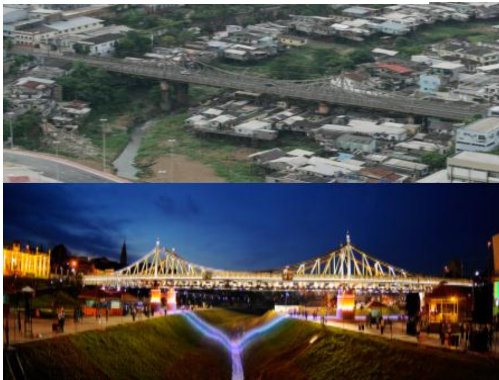
Figura 24: Ponte Benjamim Constant antes e depois do PROSAMIM.
