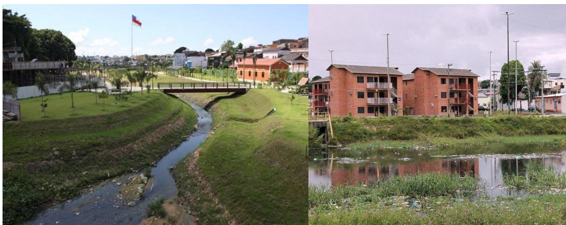
Figura 30: Presença de lixo no leito dos igarapés que deveriam ter sido revitalizados com as obras do PROSAMIM.
