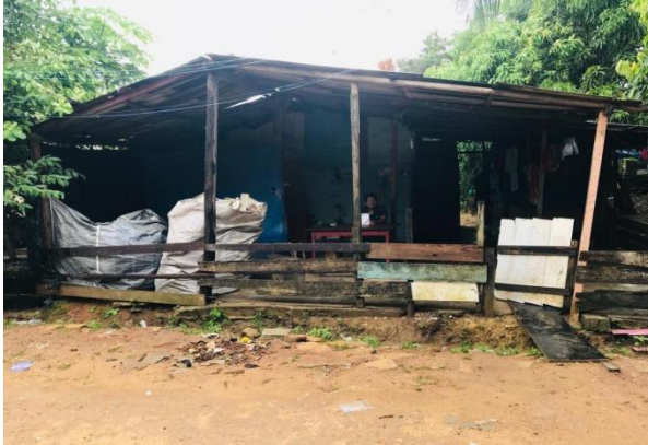
Figura 37 – Casa com refugio de construção
