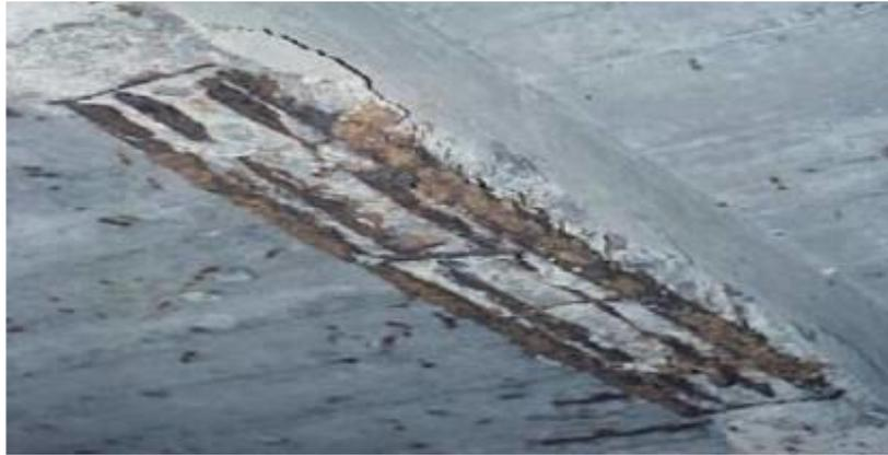
Figura 15: corrosão típica de armadura.
