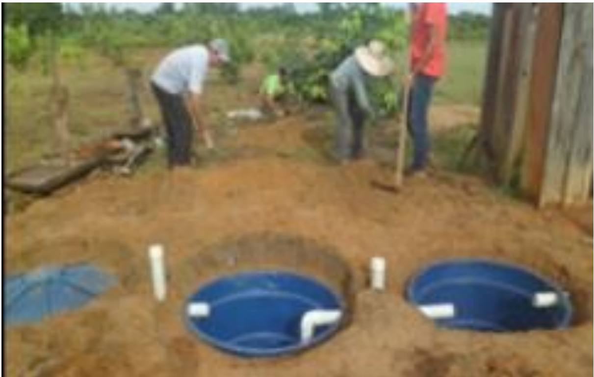
Figura 20: Instalação da fossa biodigestora (3º passo) Fonte: NUPEAS, (2016).
