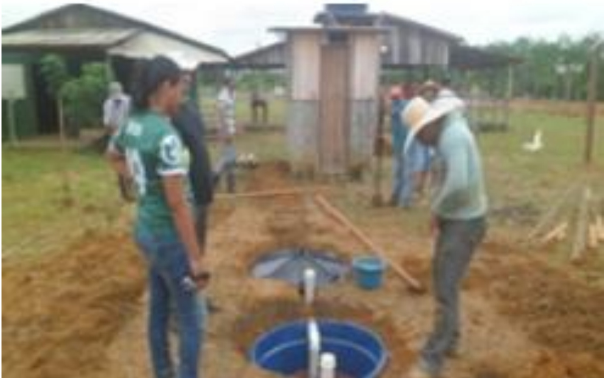
Figura 21: Instalação da fossa biodigestora (4º passo) Fonte: NUPEAS, (2016).
