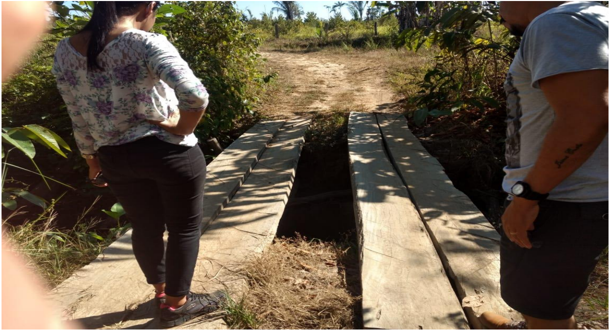
Figura 24: Ponte na vicinal Fonte: SANTOS, (2018).
