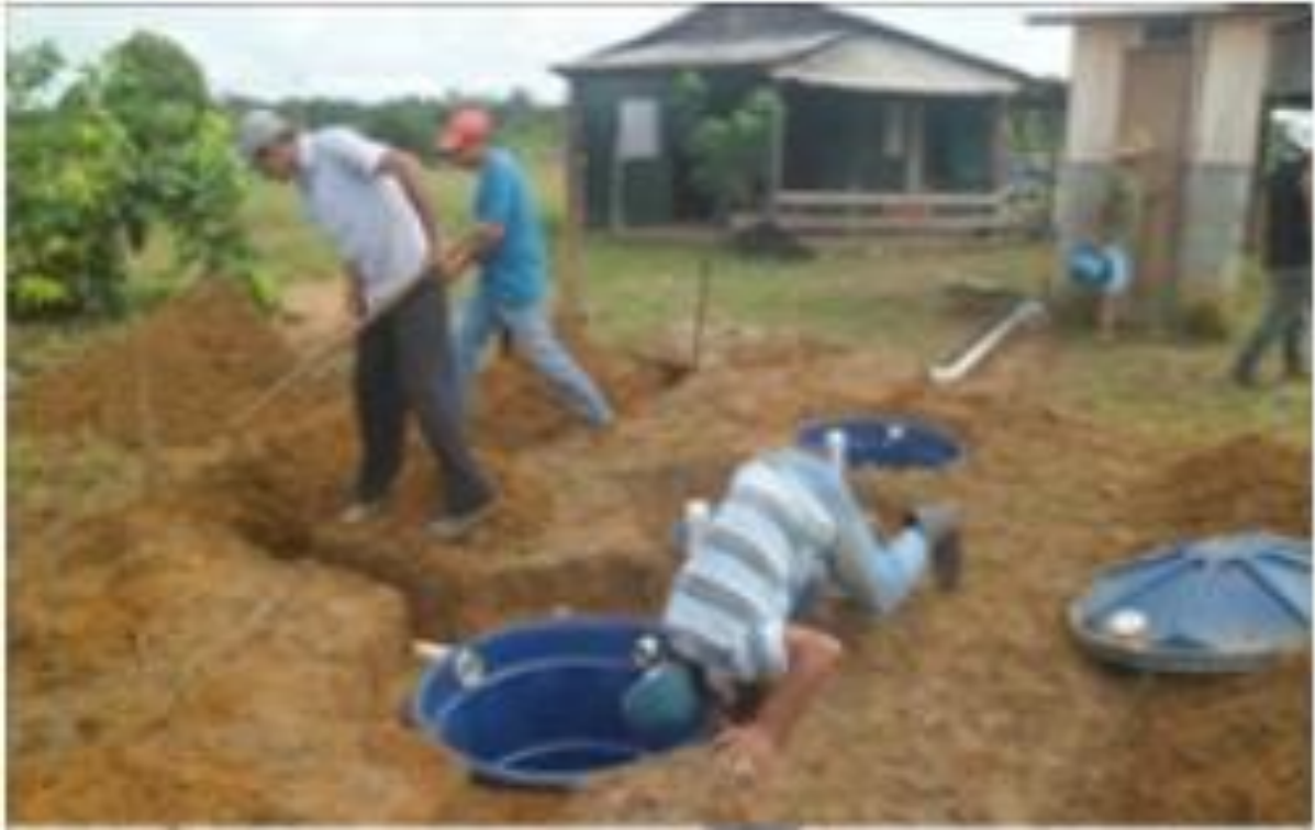
Figura 19: Instalação da fossa biodigestora (2º passo) Fonte: NUPEAS, (2016).
