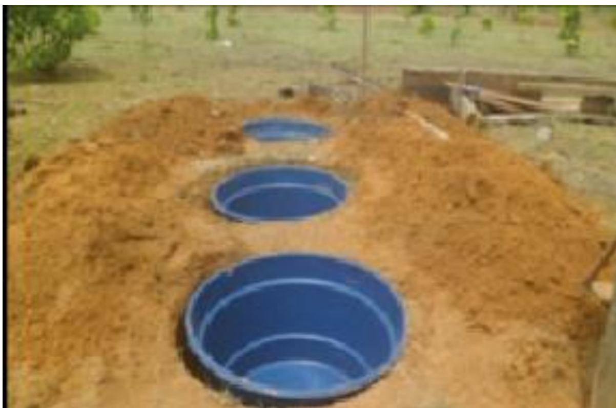
Figura 18: Instalação da fossa biodigestora (1º passo) Fonte: NUPEAS, (2016).
