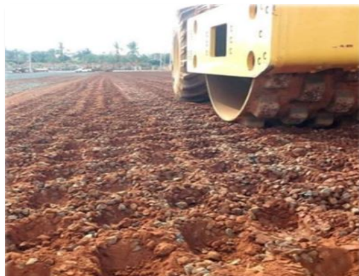
Figura 31. Aplicação de solo brita Fonte: Klinsky (2019)
