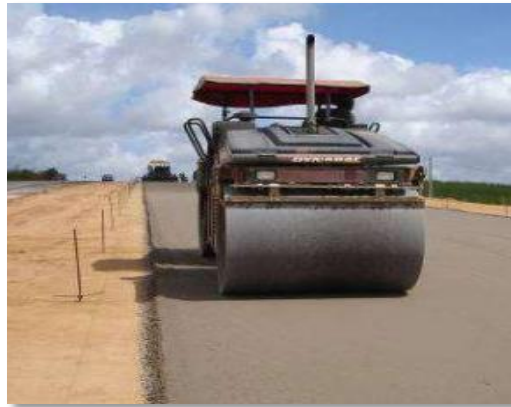
Figura 29. Aplicação de BGTC Fonte: Klinsky (2019)
