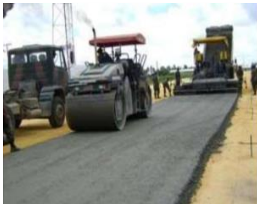
Figura 30. Aplicação de CCR Fonte: Klinsky (2019)
