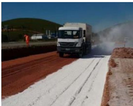
Figura 28. Aplicação de solo-cal Fonte: Klinsky (2019)
