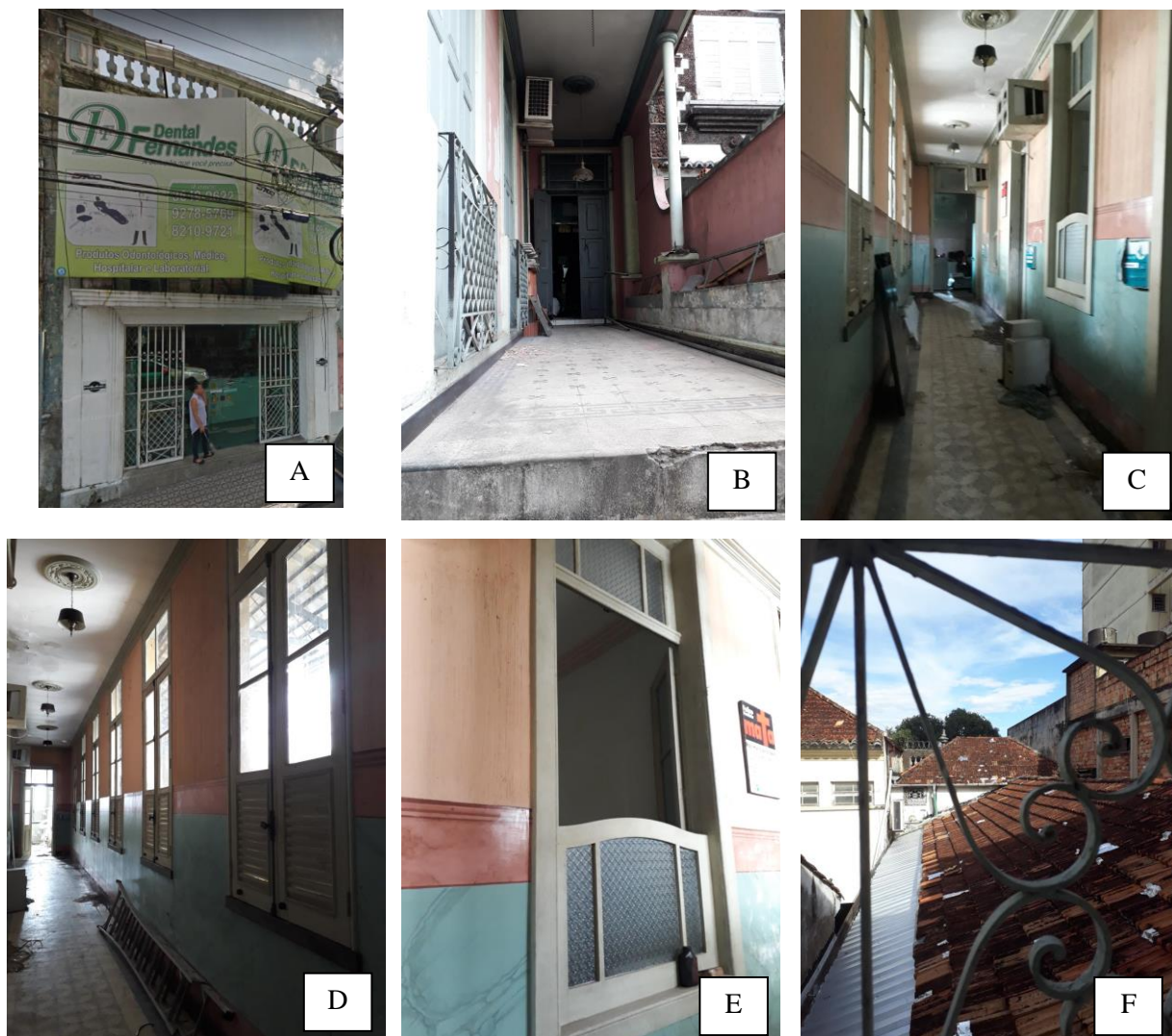
Figura 9 – Residência 05: Aspecto da fachada (A), corredor externo (B), corredor interno com esquadrias (C, D e E), cobertura em telha de barro Marselha (F)
