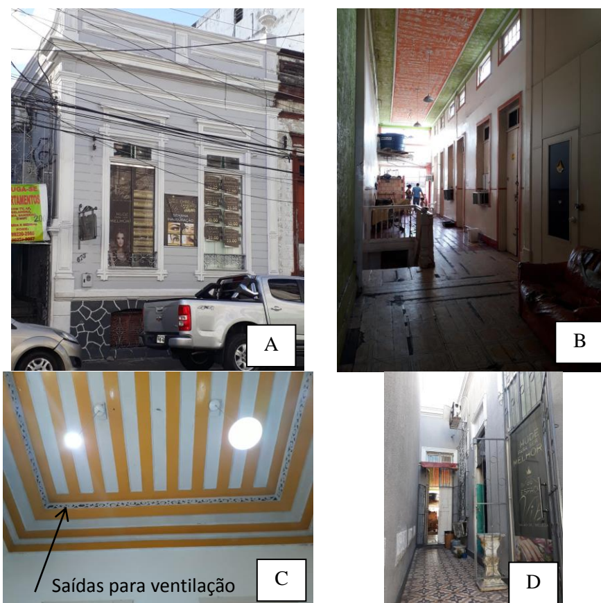
Figura 7 – Residência 03: Aspecto da fachada (A), corredor interno (B), forro com saídas para ventilação (C), corredor externo (D).
