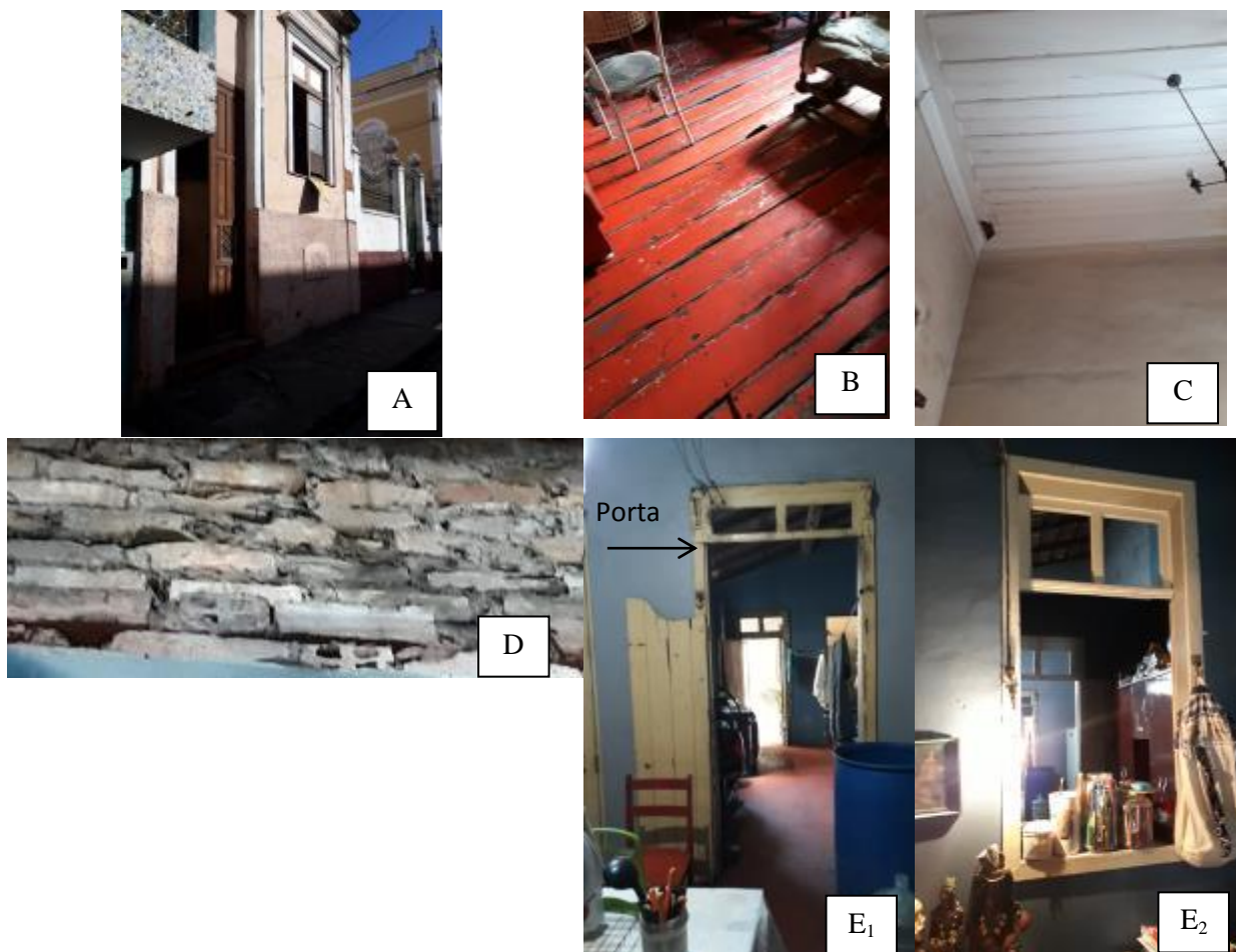
Figura 5 – Residência 01: Aspecto da fachada (A), piso em madeira (B), forro em madeira (C), tijolos utilizados nas vedações (D), porta e janela internas (E).
