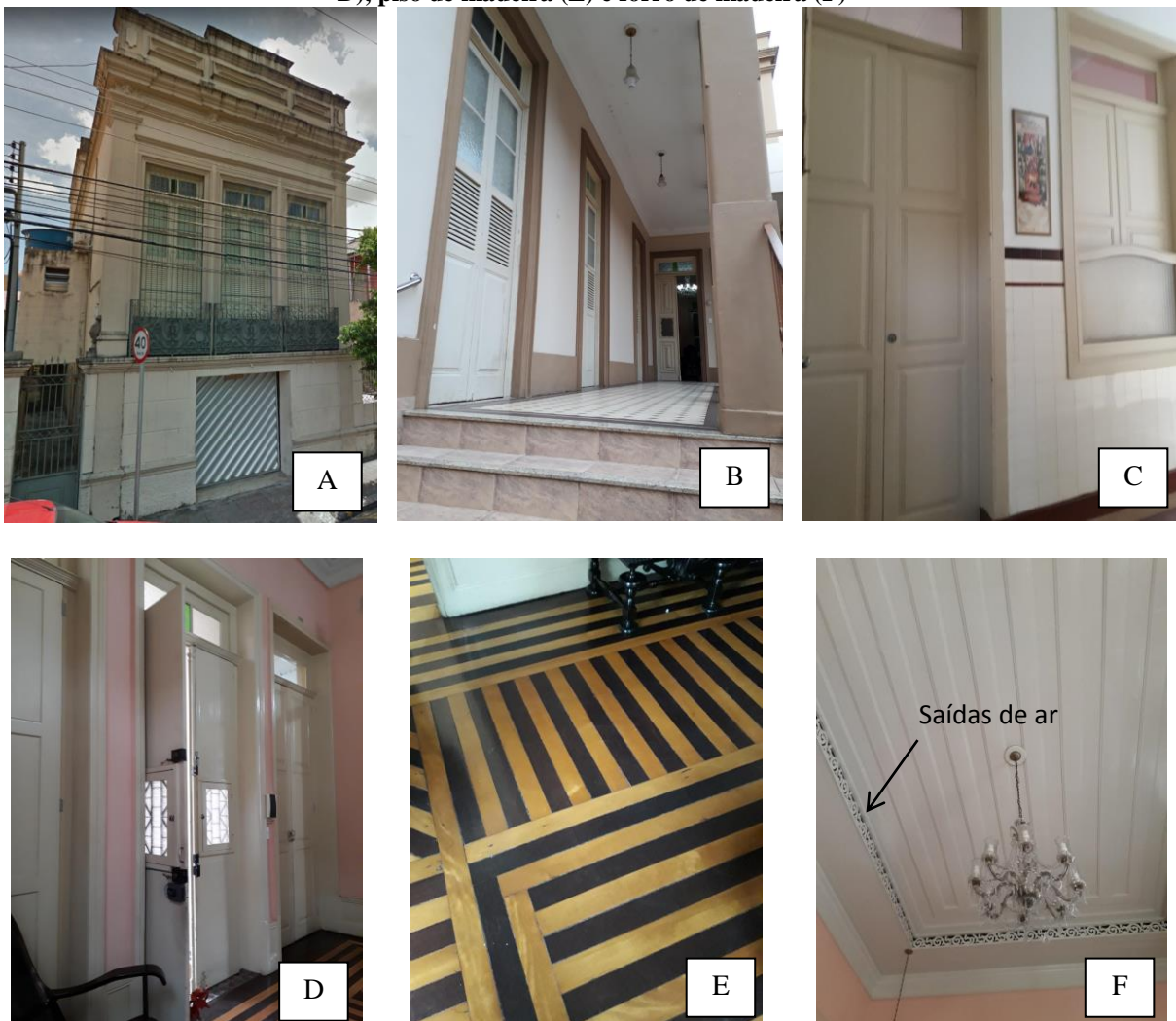
Figura 11 – Residência 07: Aspecto da fachada (A), corredor externo (B), esquadrias internas (C e D), piso de madeira (E) e forro de madeira (F)
