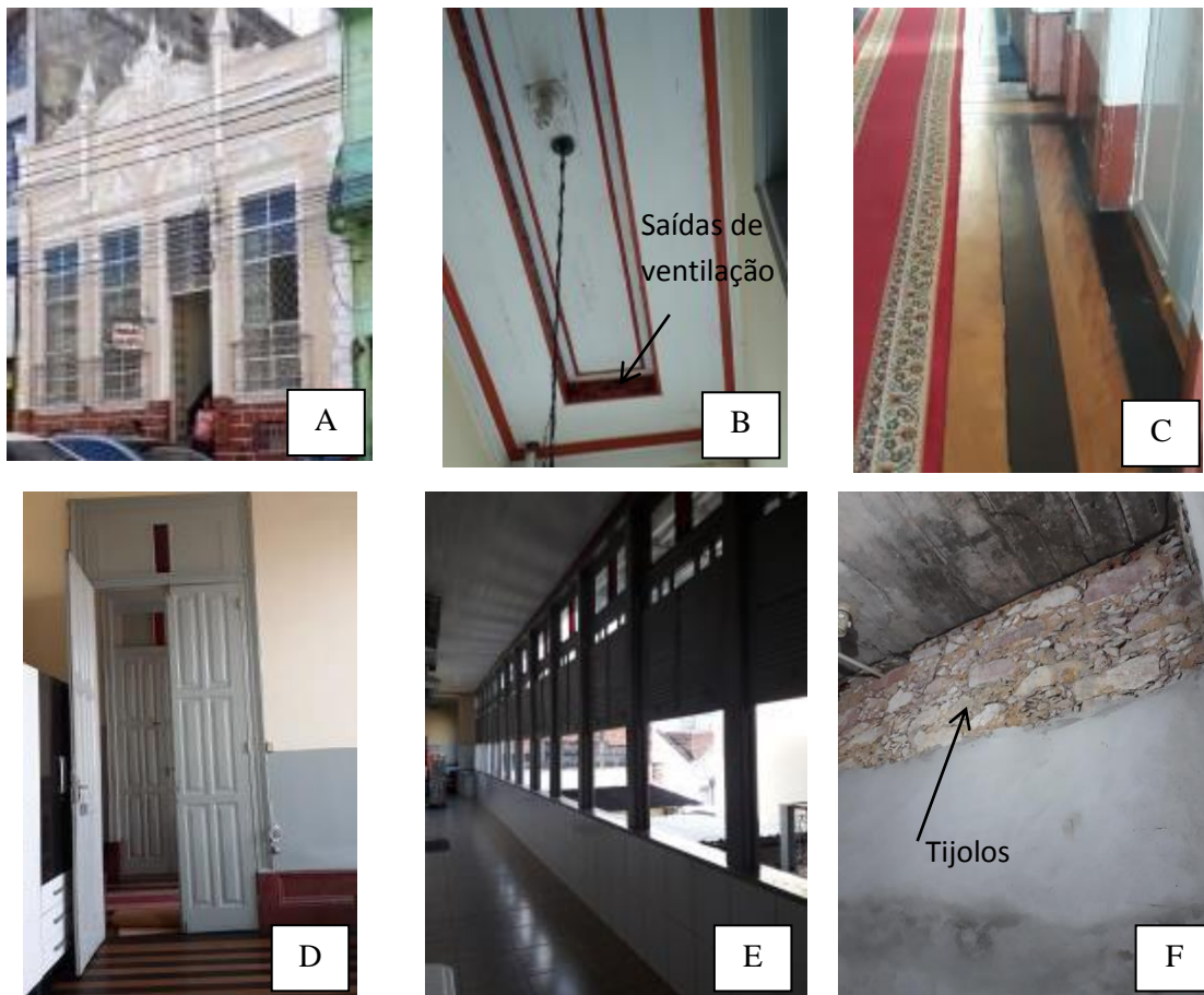
Figura 6 – Residência 02: Aspecto da fachada (A), o forro de madeira com saídas para ventilação (B), piso em madeira (C), esquadrias do quarto (D), esquadrias do corredor (E), tijolos utilizados nas paredes (F).
