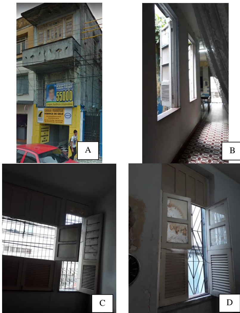
Figura 8 – Residência 04: Aspecto da fachada (A), janelas do corredor interno (B), janela da fachada (C), janela do quarto 02 (D).
