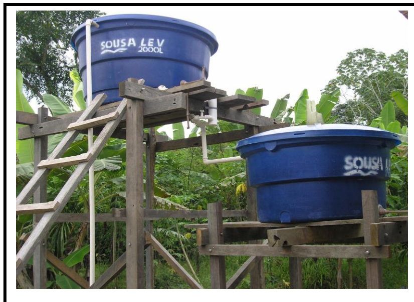
Figura 4 – Sistema de filtração e cloração da água. Fonte: Oliveira (2010).
