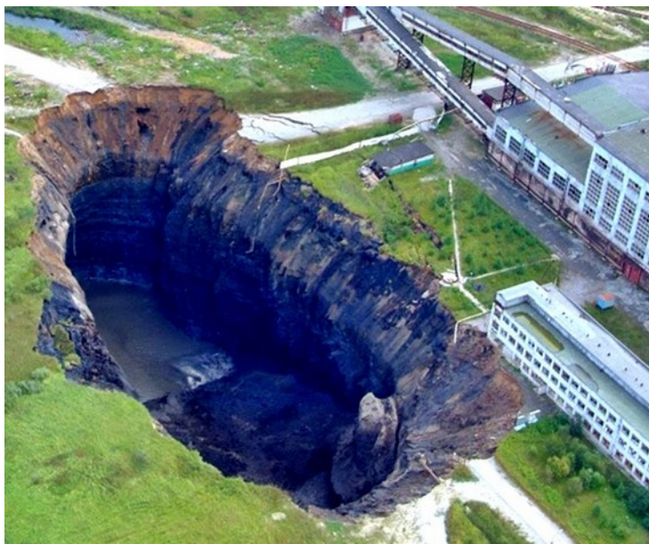
Figura 28-Crateras na cidade de Berezniki causadas por minas abandonadas de potássio. Fonte: Magnus Mundi ( www.magnusmundi.com ), 2018
