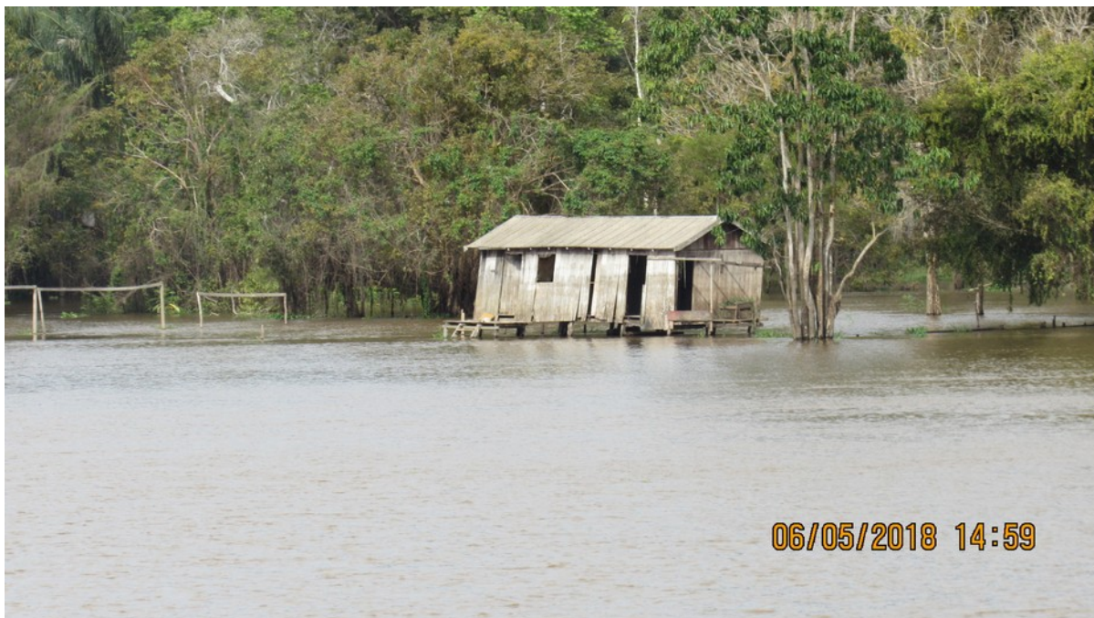
Figura 16-Casa na área de várzea do paraná do Madeirinha danificada pela ação das águas das cheias, com aparente abandono e sem condições de moradia para o seu dono. Fonte: acervo da pesquisa, 2018.
