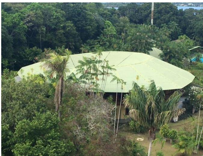
Figura 72 – Vista superior da cobertura da pousada
