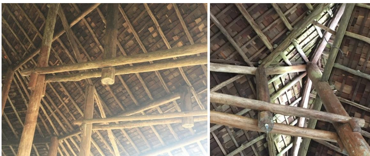
Figura 55 – Junções, disposições e encaixes do madeiramento da cobertura
