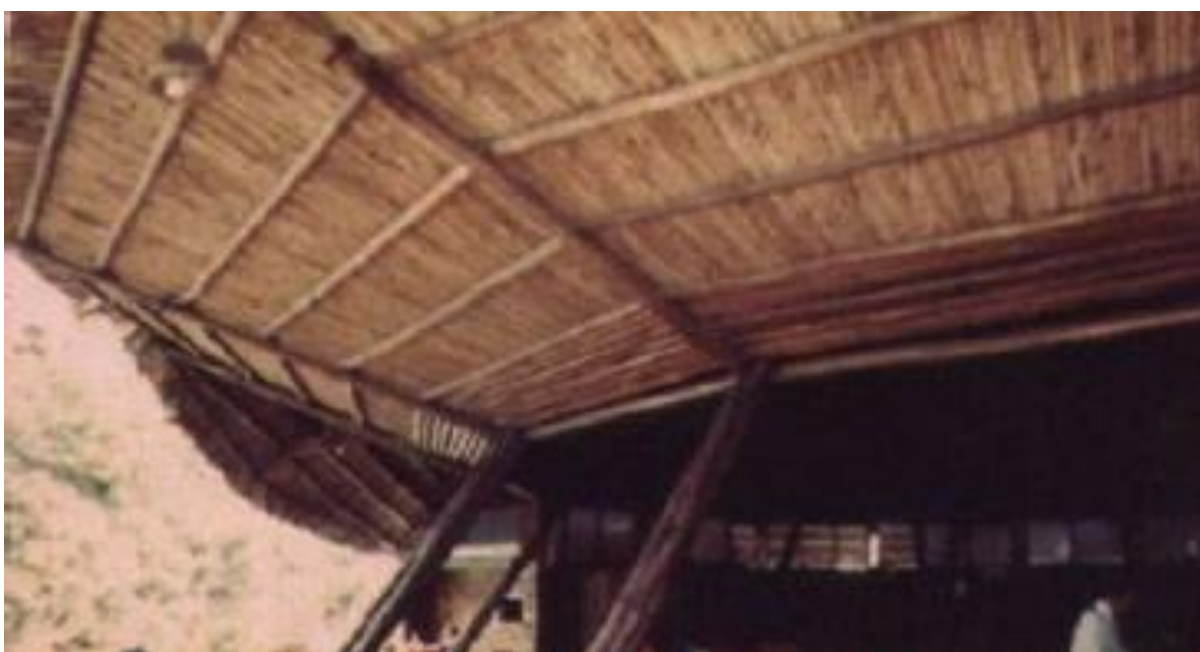
Figura 31 – Detalhe da cobertura (beiral) do restaurante
