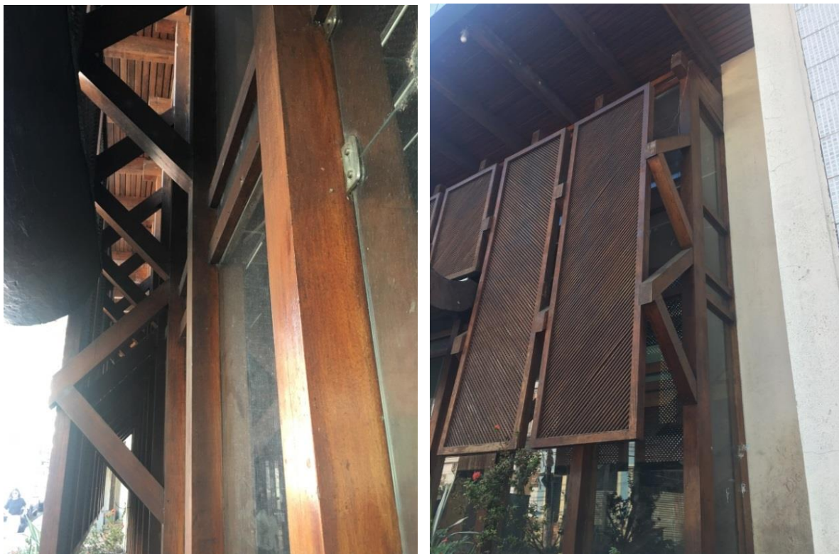
Figuras 77 e 78 – Detalhes da fachada – Banco da Amazônia
