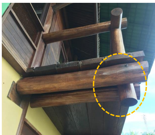
Figura 65 – Detalhes da técnica de junção e encaixe na madeira – Pousada dos Guanavenas
