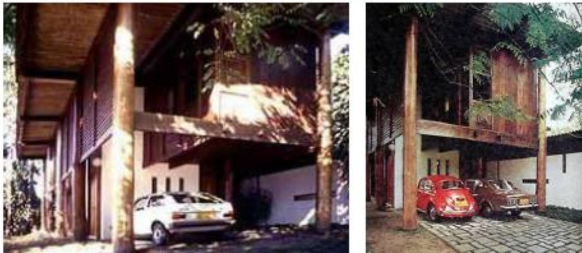
Figura 37 – Fachada norte da residência
