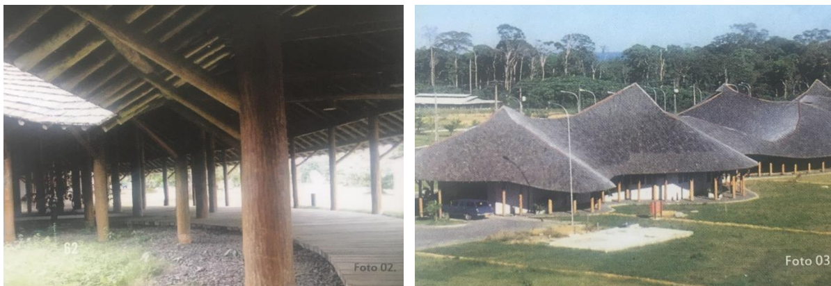
Figura 58 – Reduzidas áreas pavimentadas
