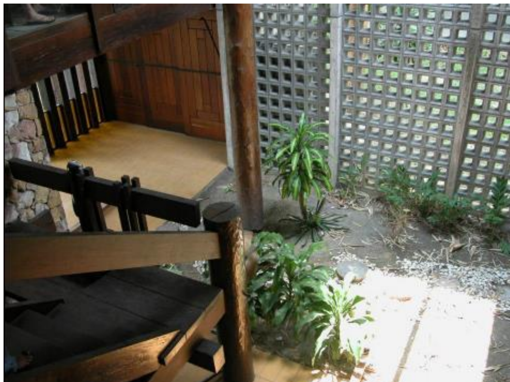
Figura 81 – Elementos vazados na parte interna da residência
