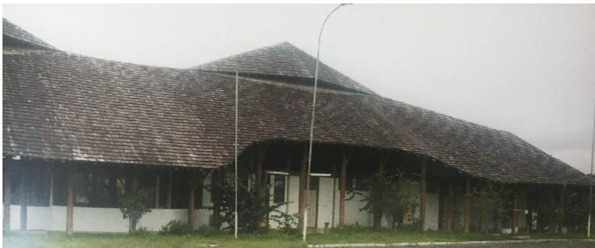
Figura 54 – Fachada do conjunto do Centro Ambiental de Balbina
