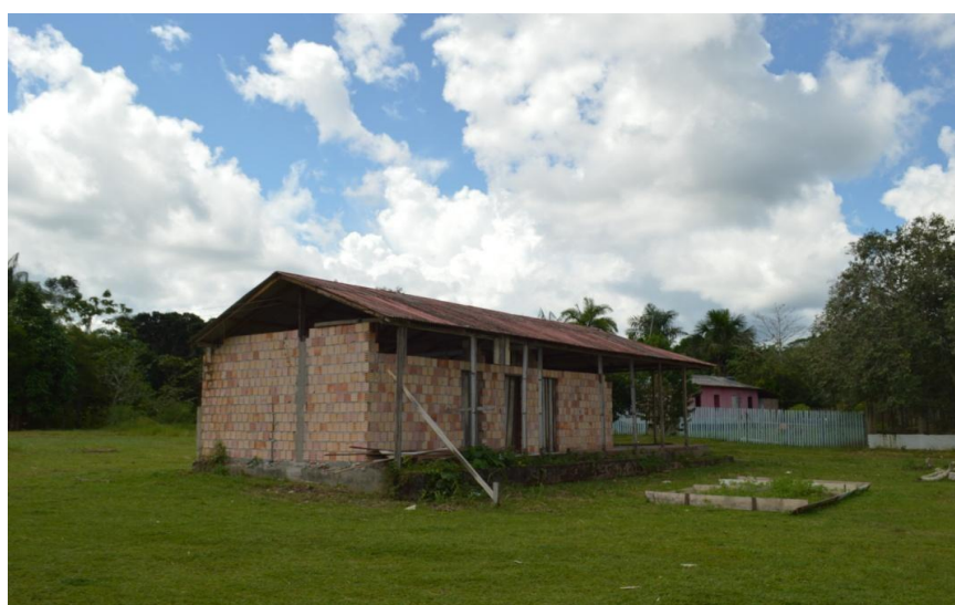
Figura 14 foto construção da escola. Por Hilkiene Alves, 19 Maio 2017.
