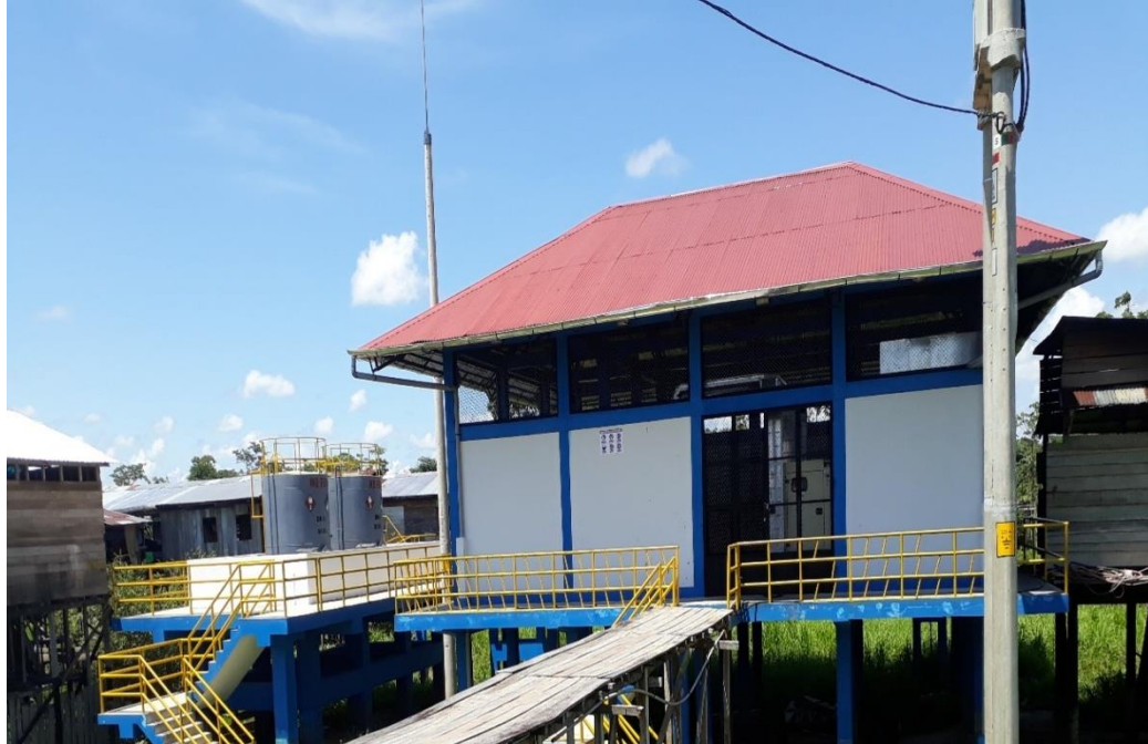
Imagem 9. Termelétrica do município de Islândia
