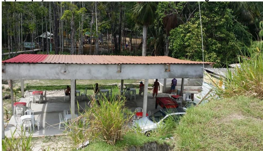
Figura (03): Espaço onde funciona um Balneário de forma irregular no RVM-nov/2019
