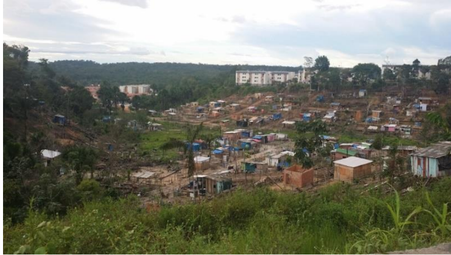
Figura (04): Entorno do Residencial Viver Melhor em processo de ocupação irregular (Março,2018).
